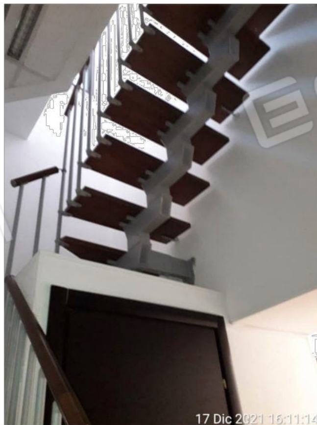
Vano Scala Ingresso al piano primo
