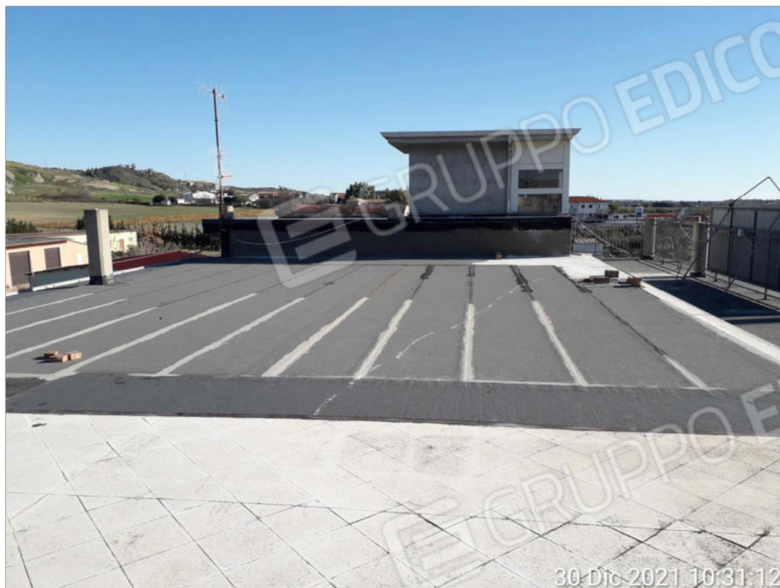
Piano Secondo – Lastrico solare
