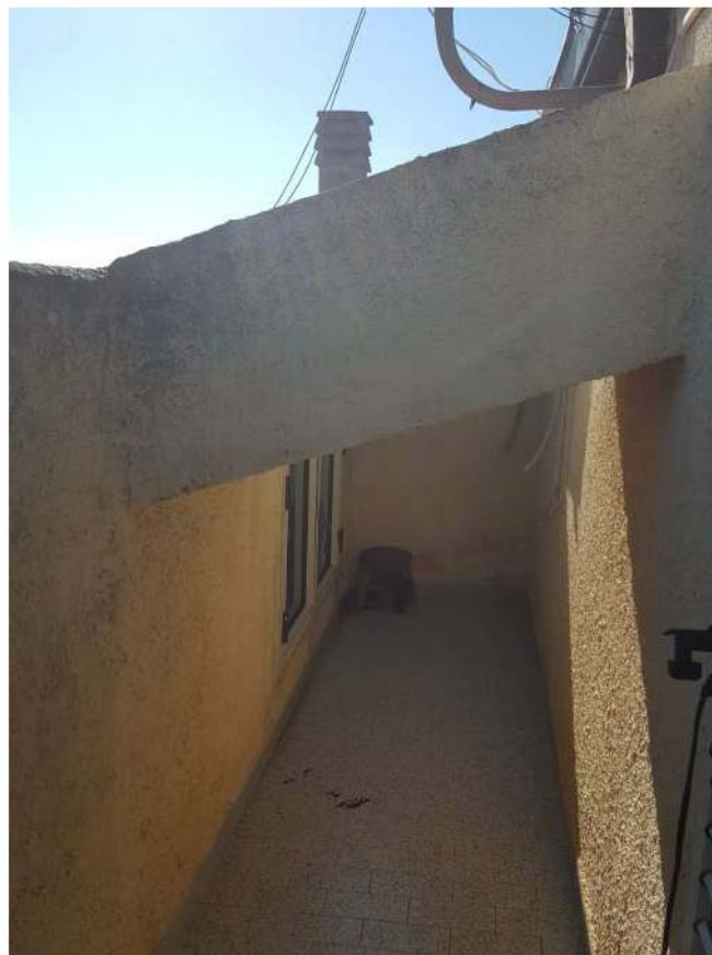
Balcone lato Est
