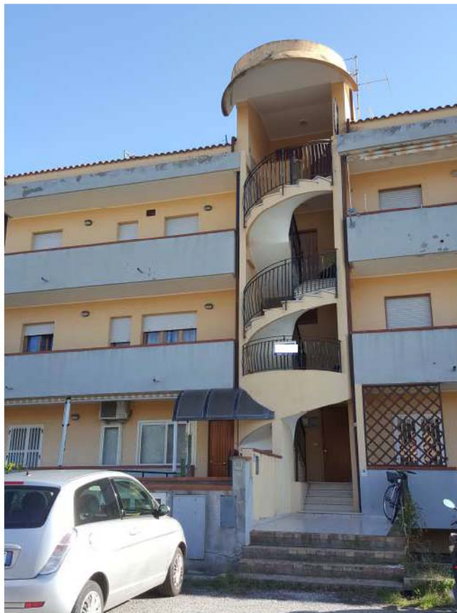
Scala condominiale di accesso all'immobile
