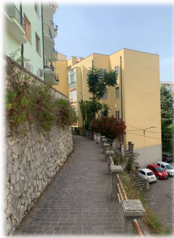
Figura 10: rampa di accesso da Bellavista
