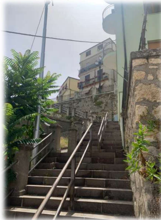
Figura 9: scale di collegamento tra portone e Bellavista
