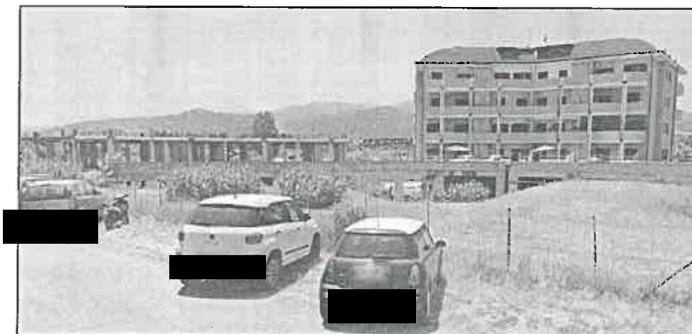
Figura 11 - Corpo A in corso di costruzione - Lotto 1
