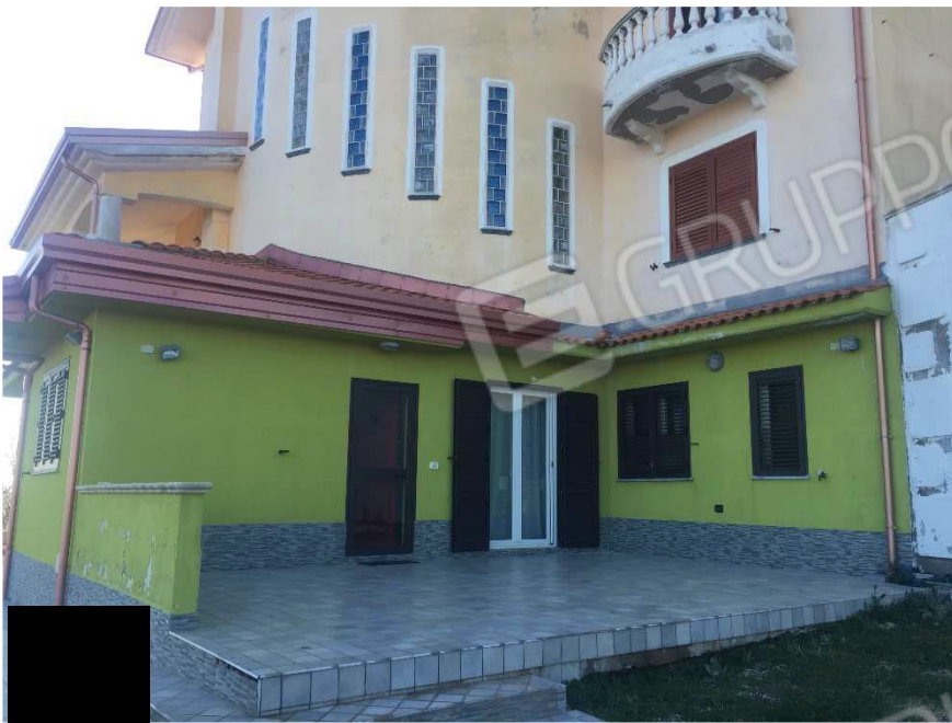
Foto 5 – Veduta esterna ingresso piano seminterrato
