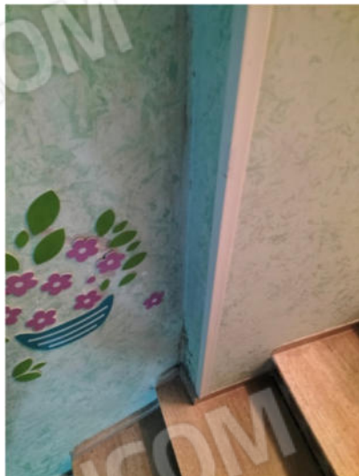
Foto 10. Primo Piano. Scala di collegamento: Particolare.
