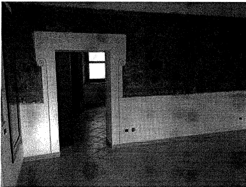
Figura 6 – Locale da adibire ad attività commerciale (sub 4)
