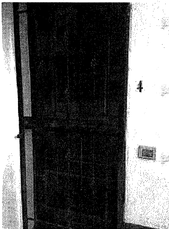
Figura 5 – Ingresso al sub 4
