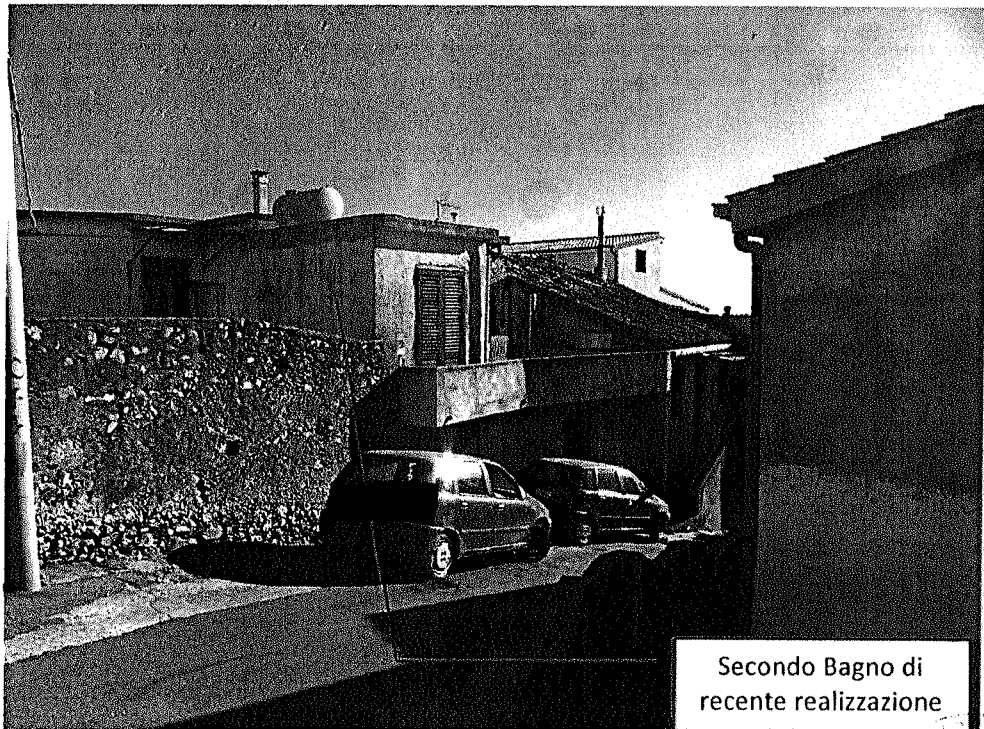
Foto n. 3: Vista esterna dell'unità oggetto di Pignoramento da Via Leonardo Da Vinci
