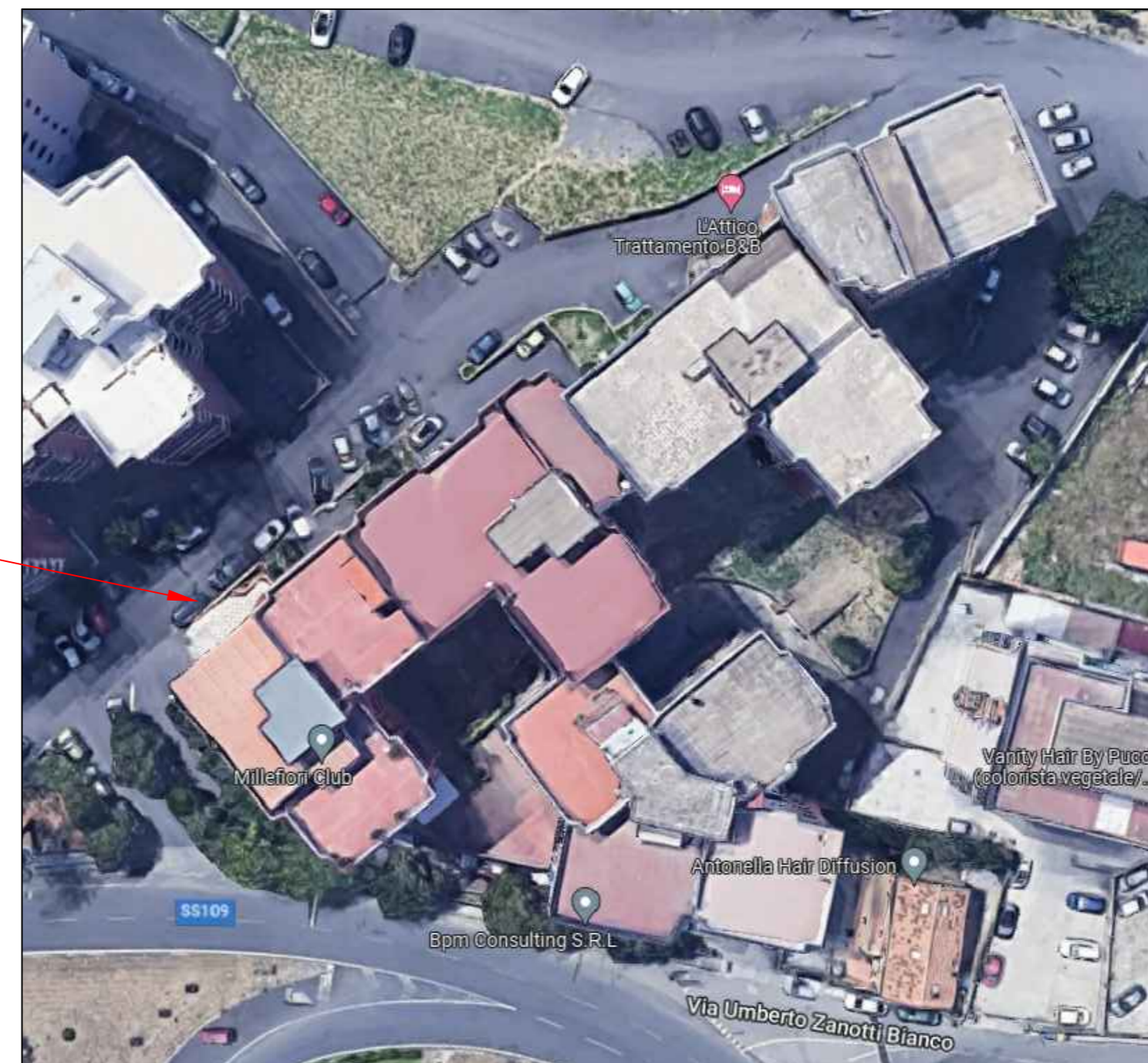
ORTOFOTO - DETAGLIO FABBRICATO
