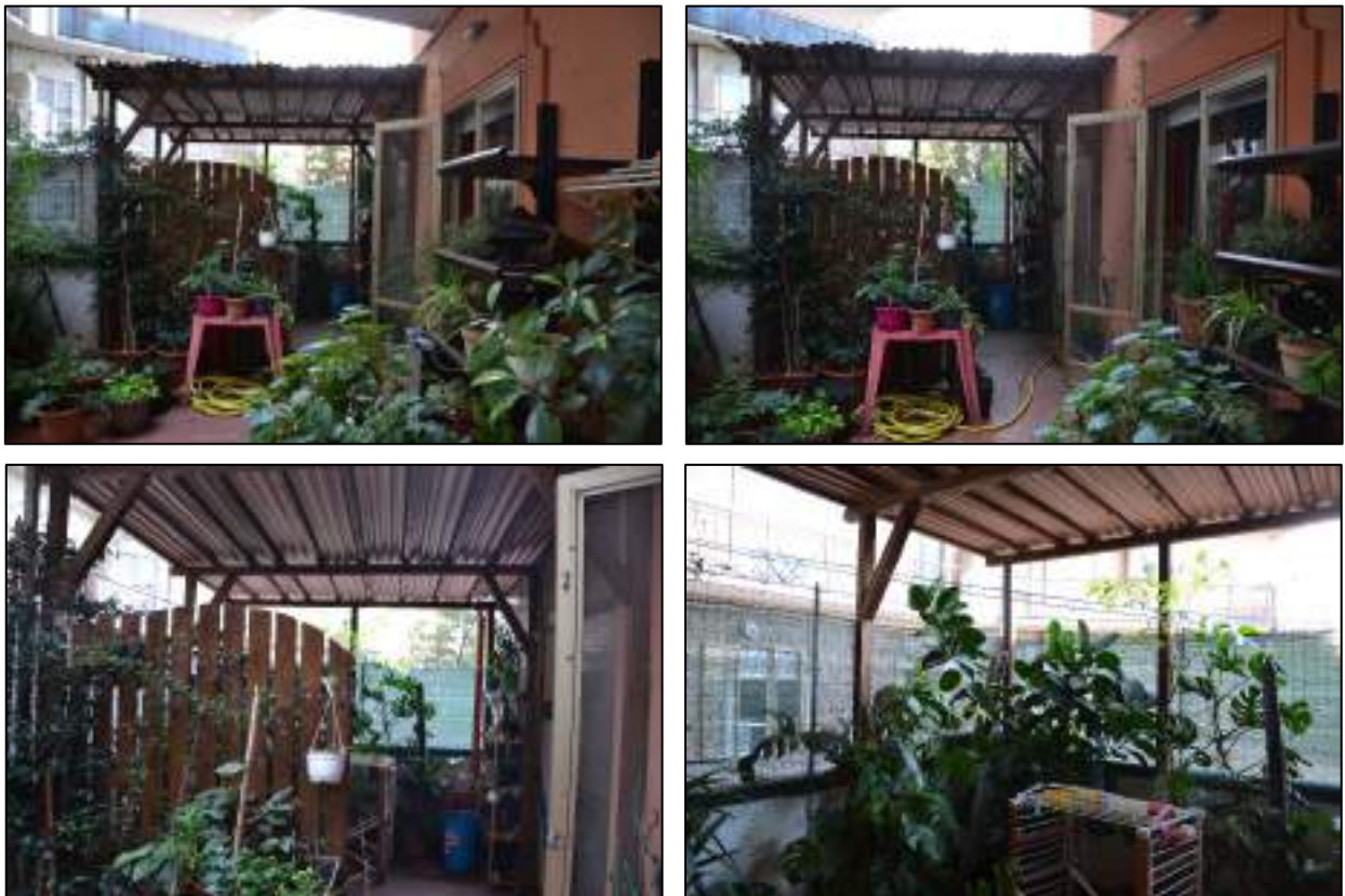
Figura 9 – Tettoia insistente sul terrazzo
