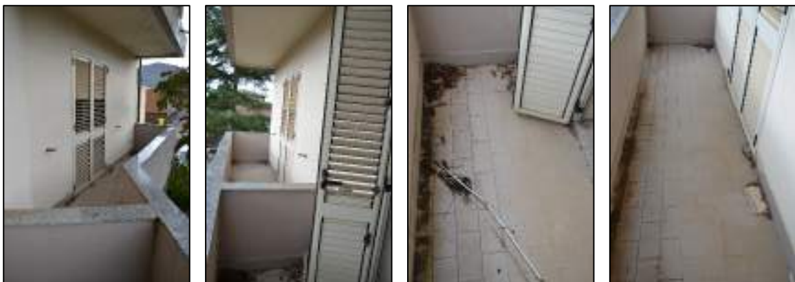
Figura 29 - Balconi posti al piano primo
