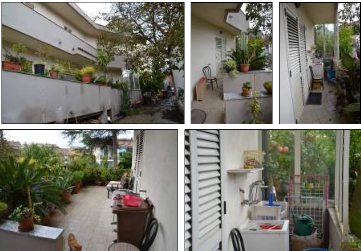
Figura 28 – Ballatoio posto al piano terra rialzato
