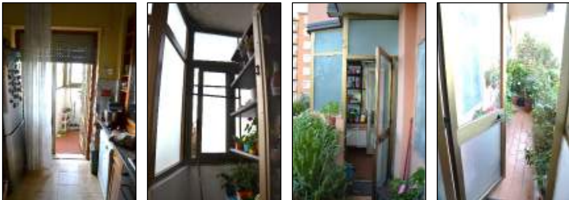
Figura 11 - Balcone parzialmente occupato da veranda
