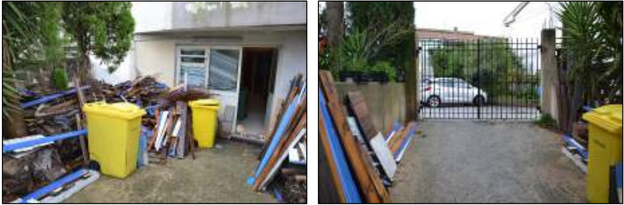
Figura 19 - Accesso al piano seminterrato
