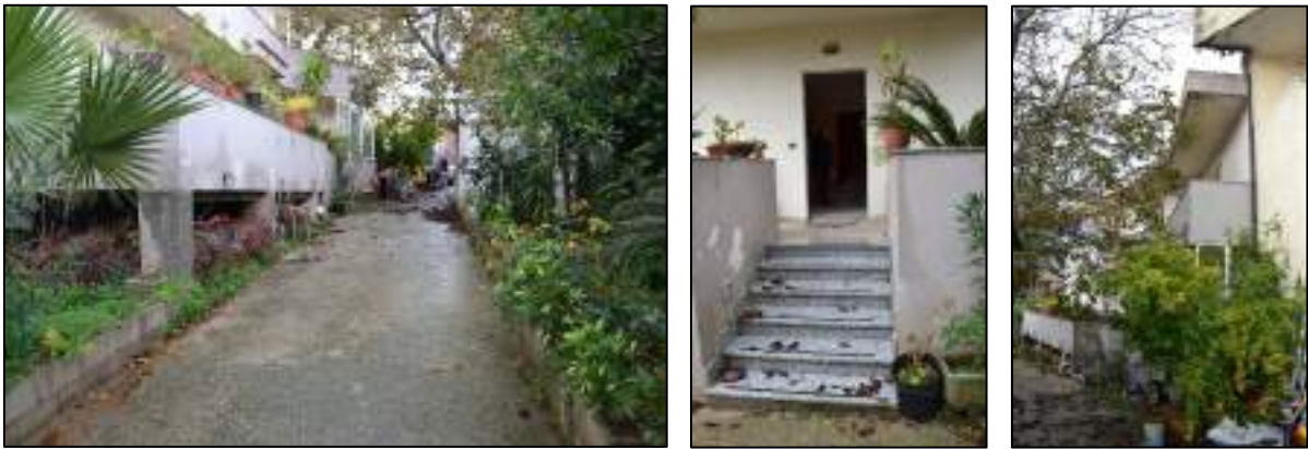
Figura 20 - Accesso al piano terra
