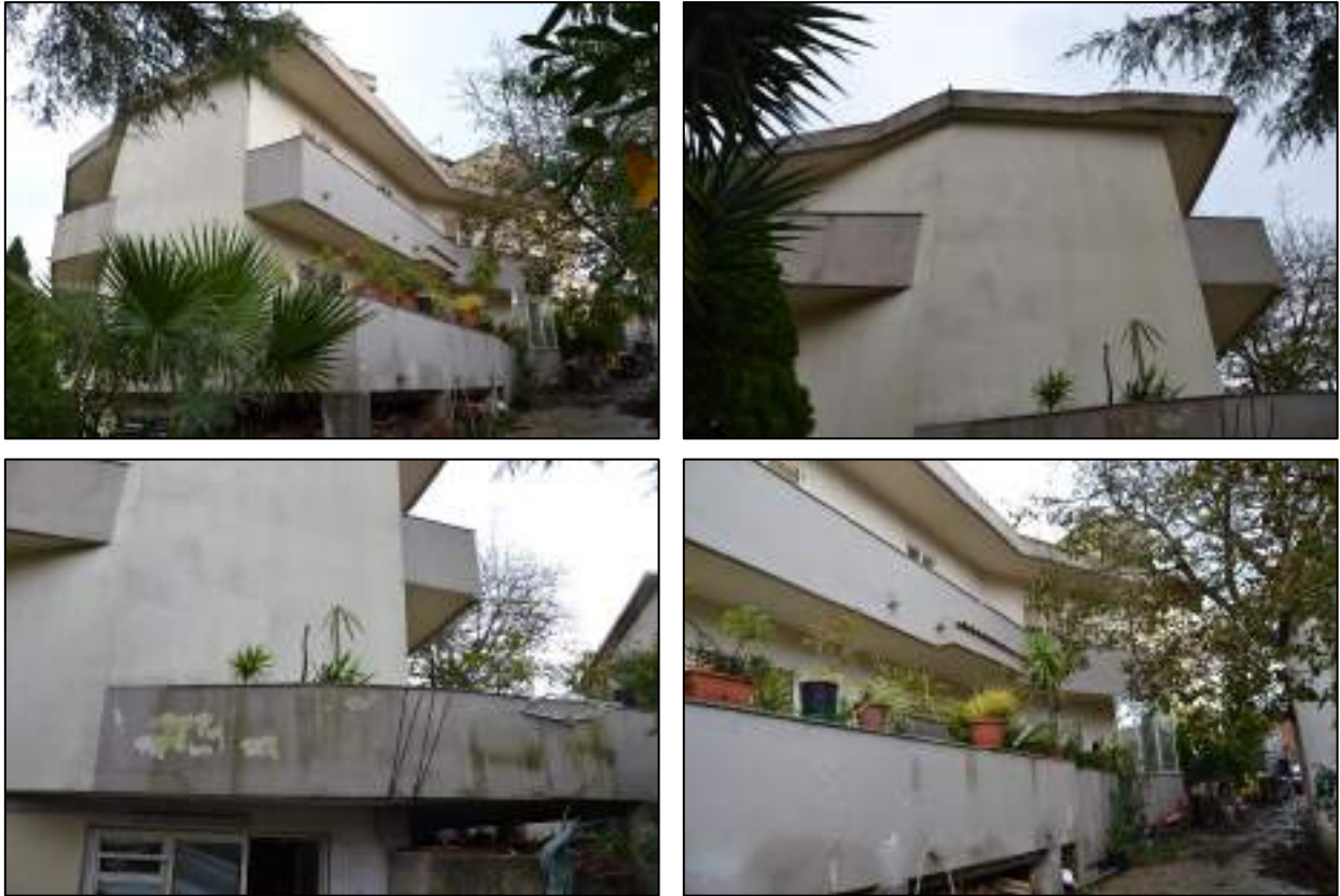
Figura 26 - Vista di insieme del fabbricato – Comune di Caraffa di Catanzaro
