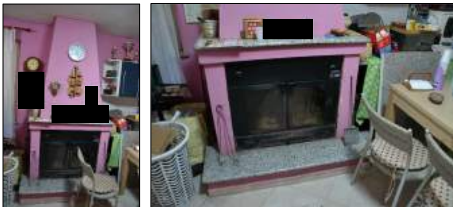
Figura 40 – Impianto di riscaldamento e produzione di acqua calda sanitaria
