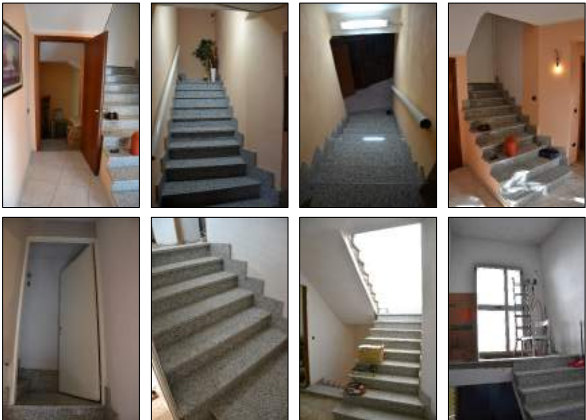
Figura 27 - Vano scala interno
