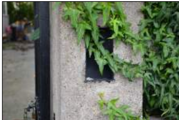
Figura 39 - Predisposizione impianto citofonico
