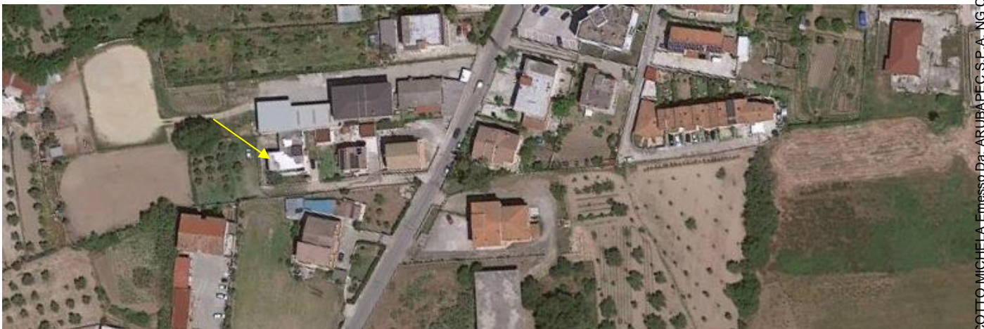
Fig. Foto aeree Fabbricato da Google Earth pro
