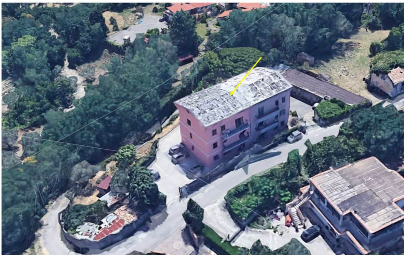
Fig. Foto aeree Fabbricato da Google Earth pro
