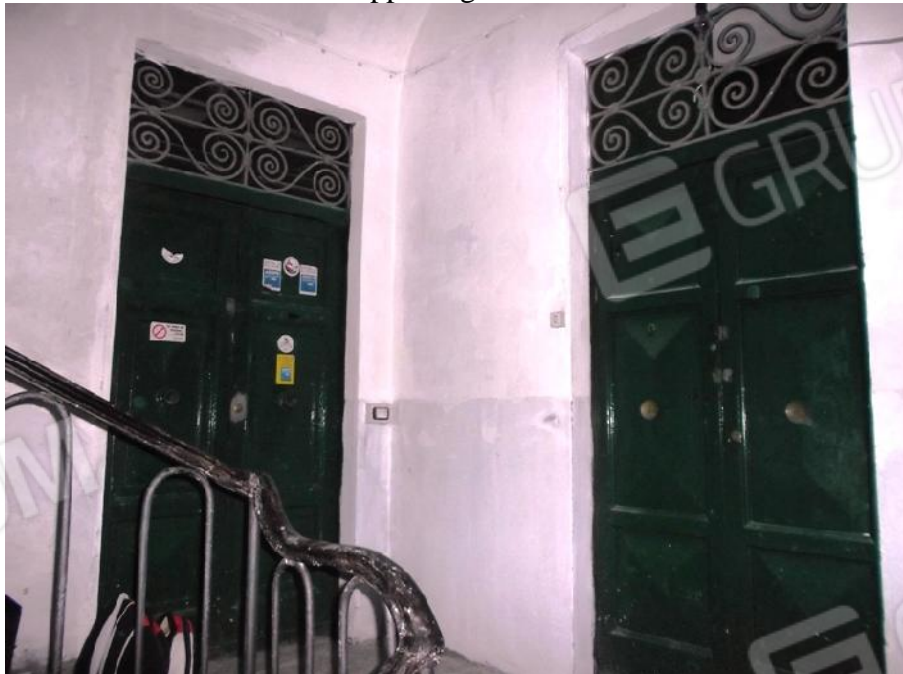
Portoncini del doppio ingresso nel vano scala
