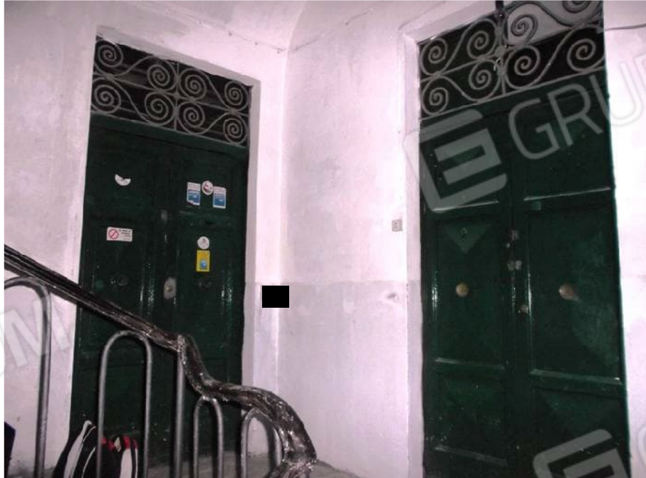
Portoncini del doppio ingresso nel vano scala
