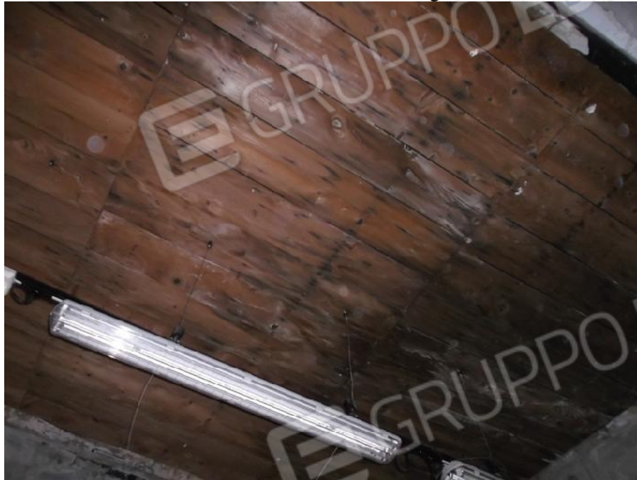
Particolare del soffitto in legno
