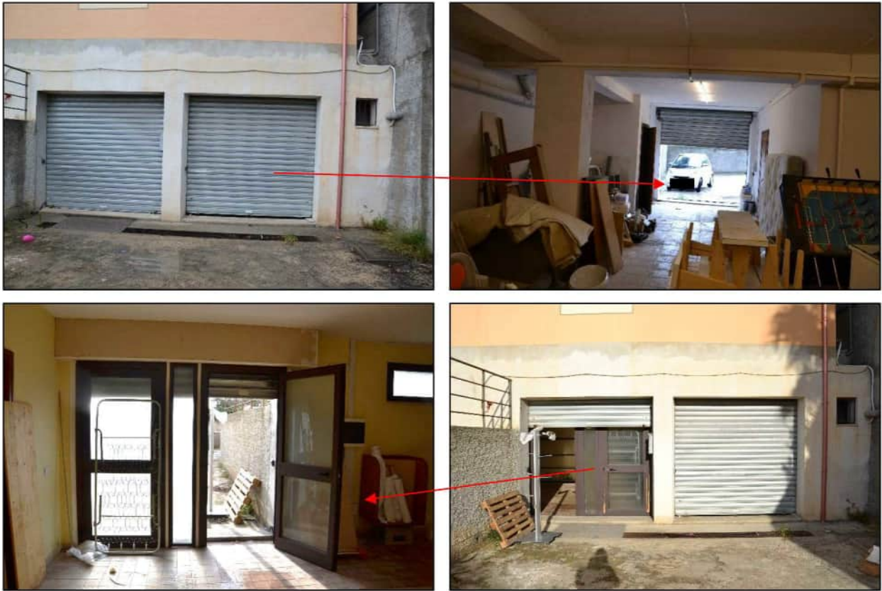
Figura 11 - Ingresso al DEPOSITO 1 (sotto) e al DEPOSITO 2 (sopra)
