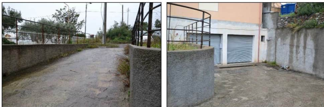
Figura 6 – Ingresso all'unità immobiliare dall'area esterna costituita da rampa
