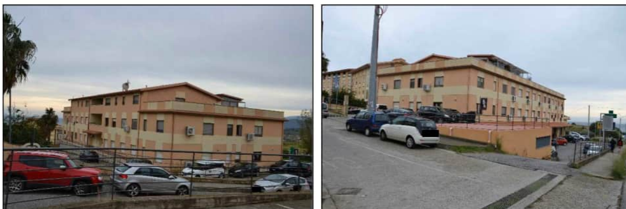
Figura 9 - Vista di insieme del fabbricato
