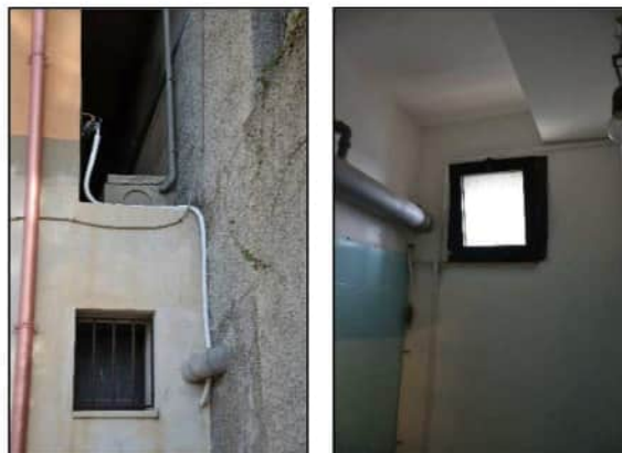
Figura 13 - Infisso presente nel vano WC
