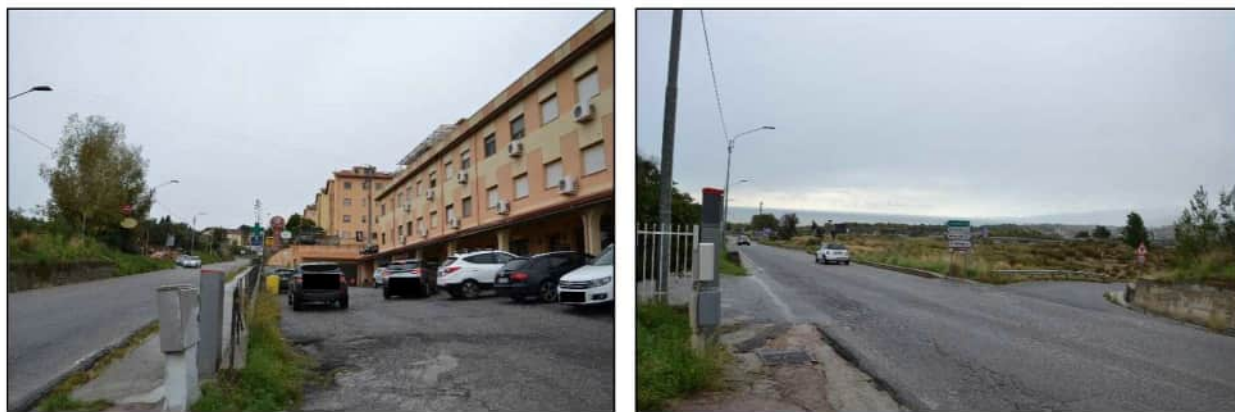
Figura 5 - Raggiungibilità del fabbricato - viale Europa (ovvero SP48) che si dirama direttamente dalla SS280 – Ingresso I1
