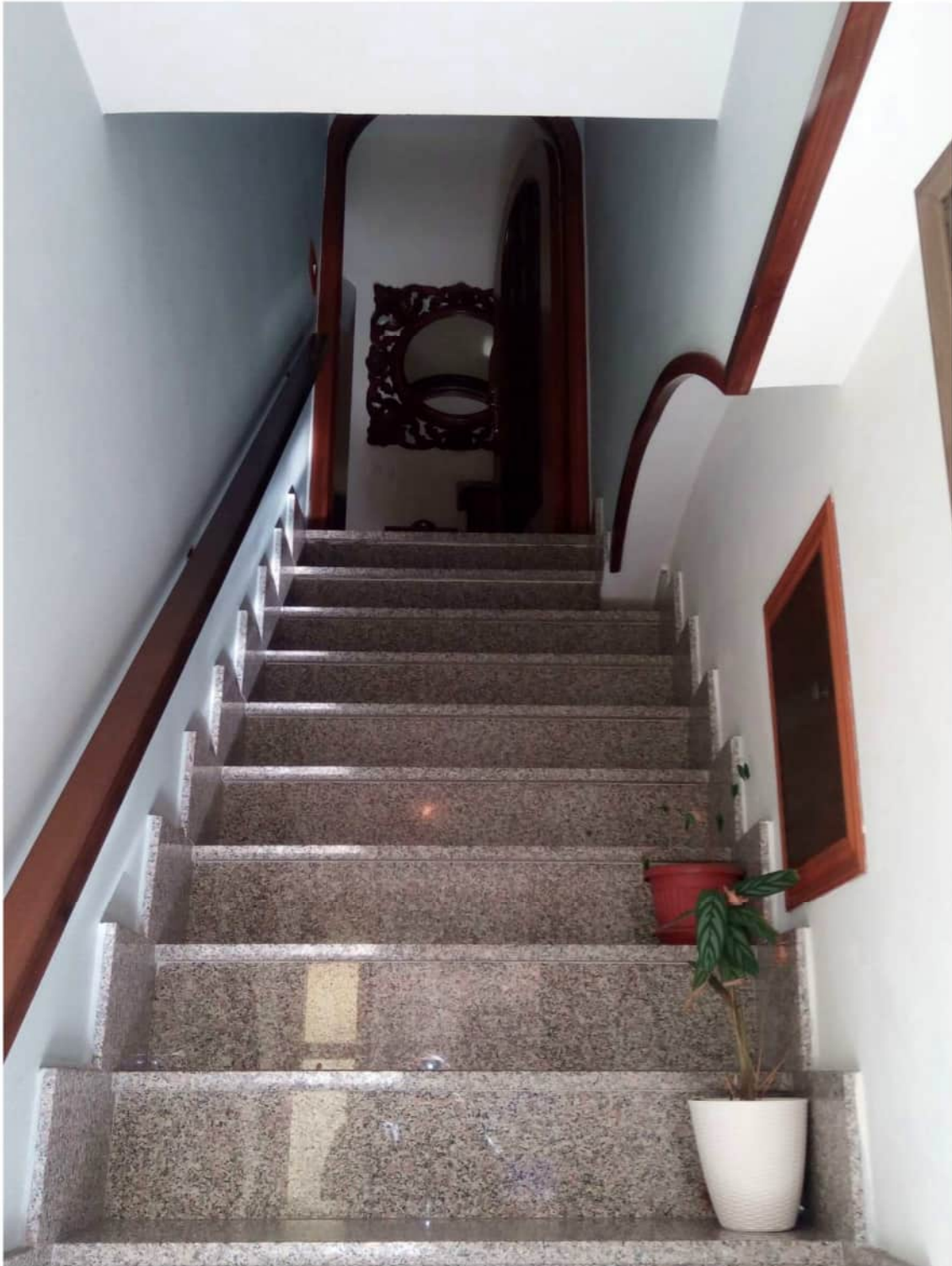
SCALA INTERNA DI ACCESSO
