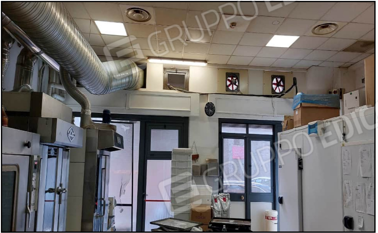
Foto 3. Vista dall'interno del locale dei due infissi
