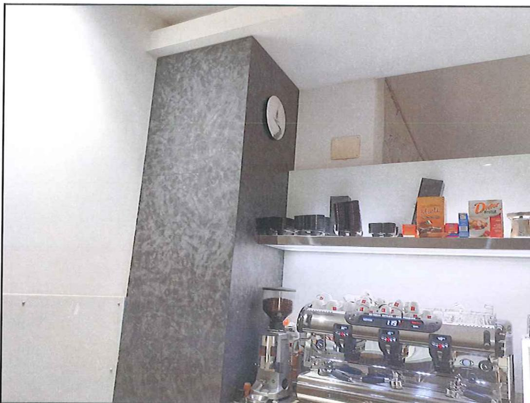
**Foto 7. Particolare di un pilastro rivestito in cartongesso dietro il banco bar**
