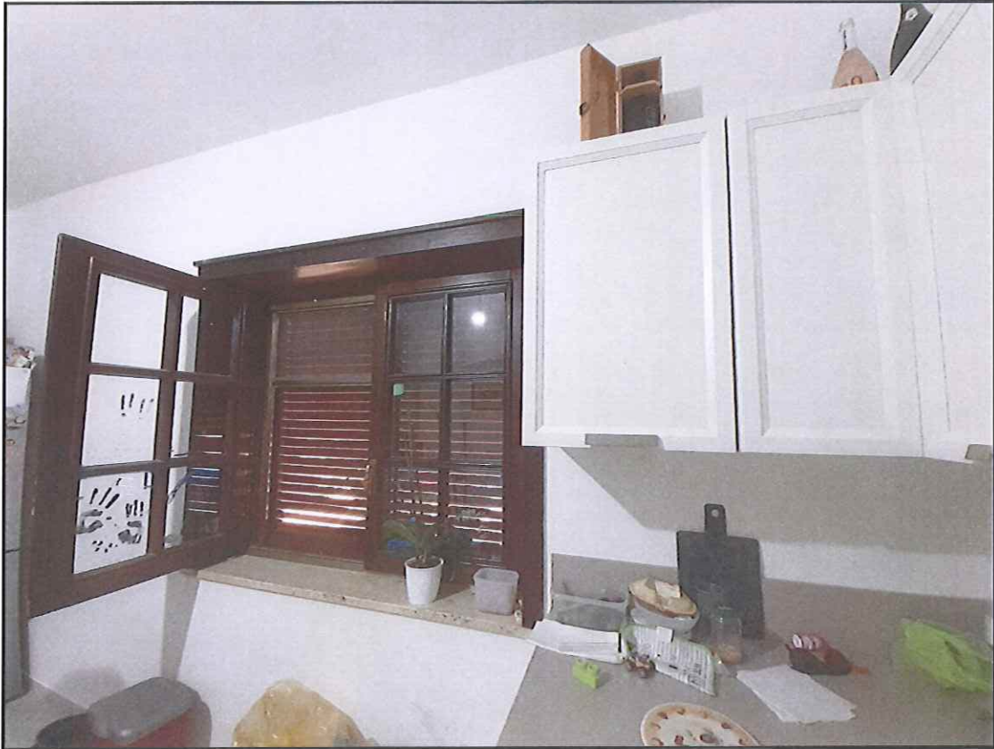
Foto 7. Infisso e pensili del vano cucina
