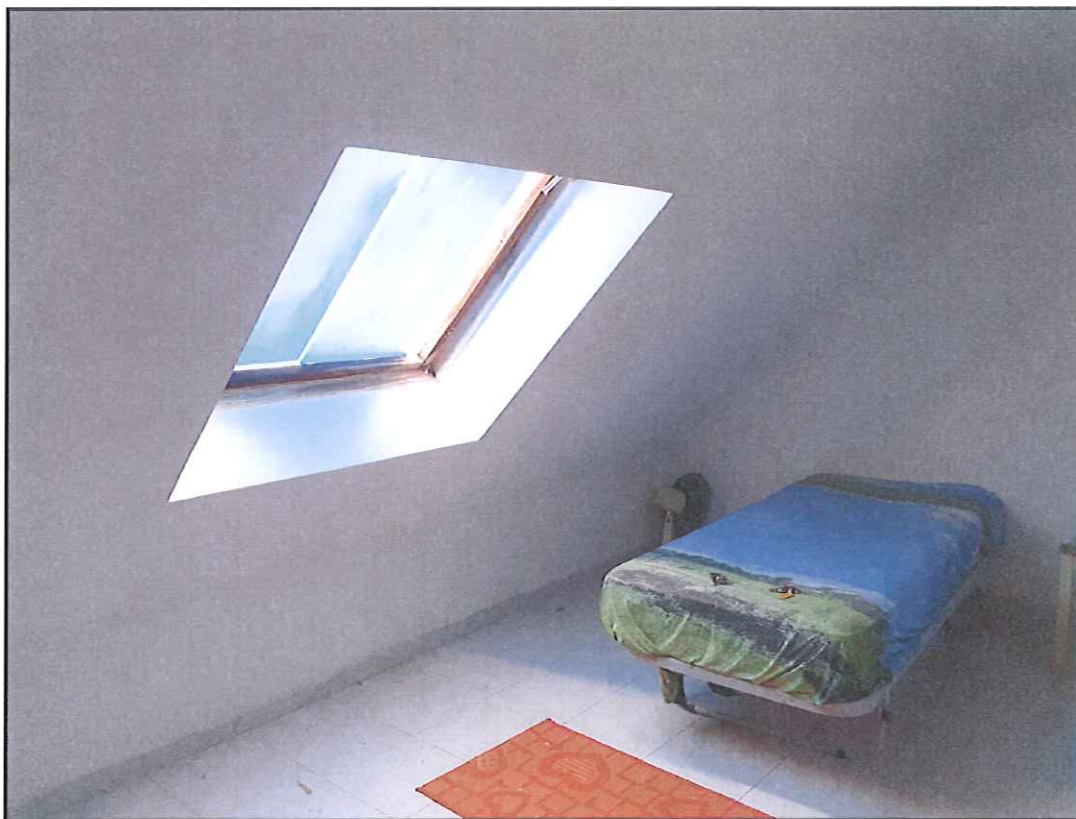
Foto 24. Vista lucernaio e letto nel locale sottotetto
