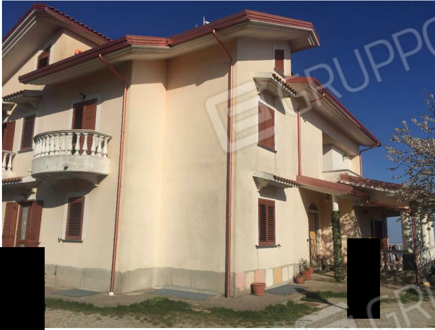
Foto 1- Veduta esterna villino
