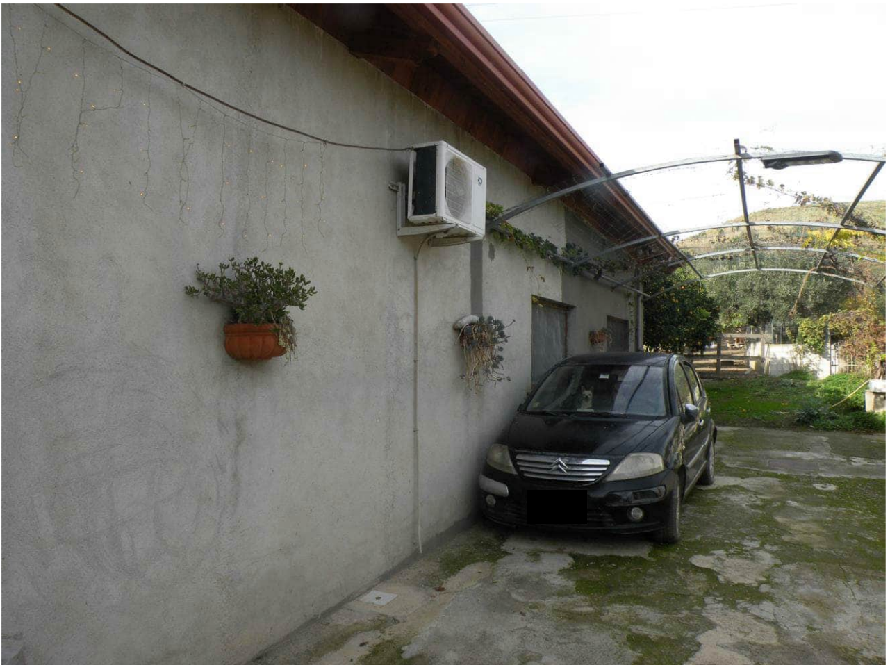
Foto n° 2 – Immobile censito nel N.C.E.U. al fg 25 par.la 115 – Prospetto Est
