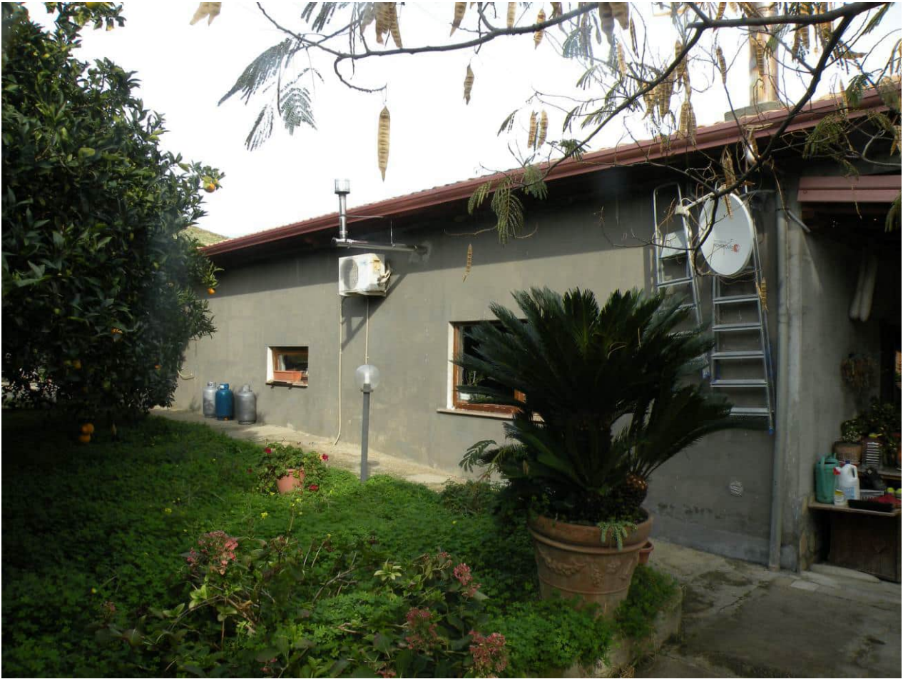
Foto n° 5 – Immobile censito nel N.C.E.U. al fg 25 par.lla 115 – Prospetto Ovest
