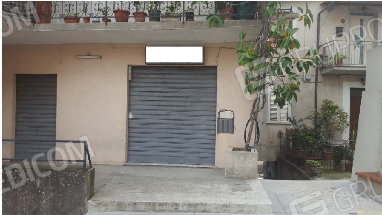
FOTO N.4 – Accesso dell'immobile in Piazza Carmine n.36, comune di Guardavalle, censito al Catasto al foglio n. 30, p.lla n. 1544, sub. n. 3, piano terra.
