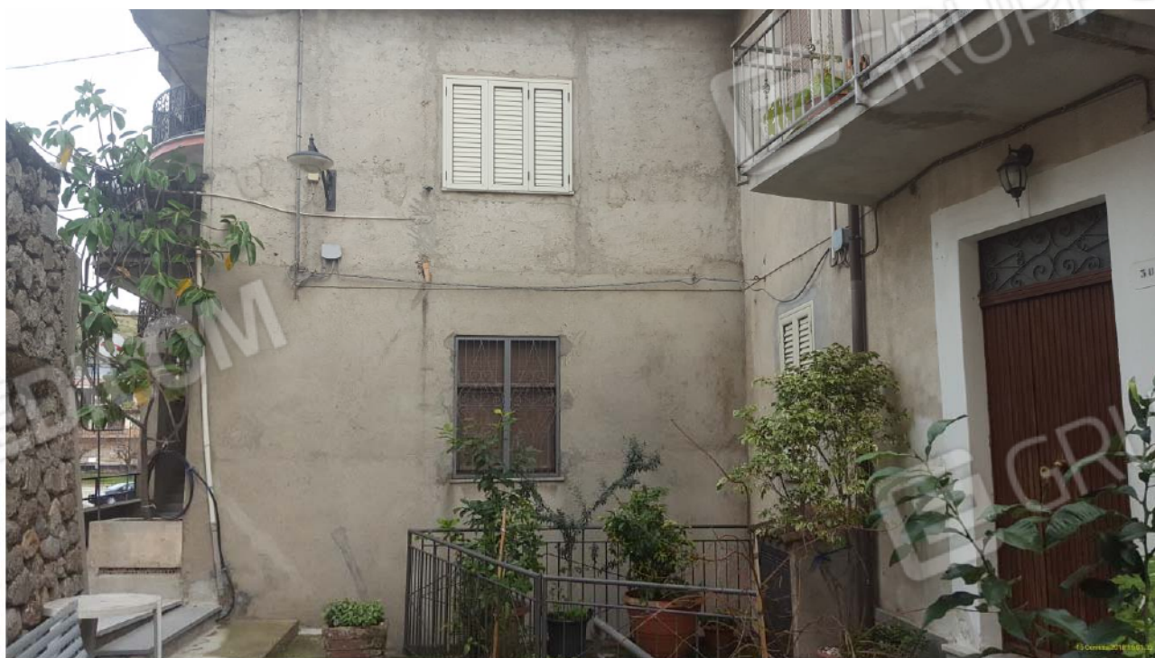
FOTO N.2 – Inquadramento del fabbricato ubicato in Piazza Carmine, prospetto laterale (OVEST).
