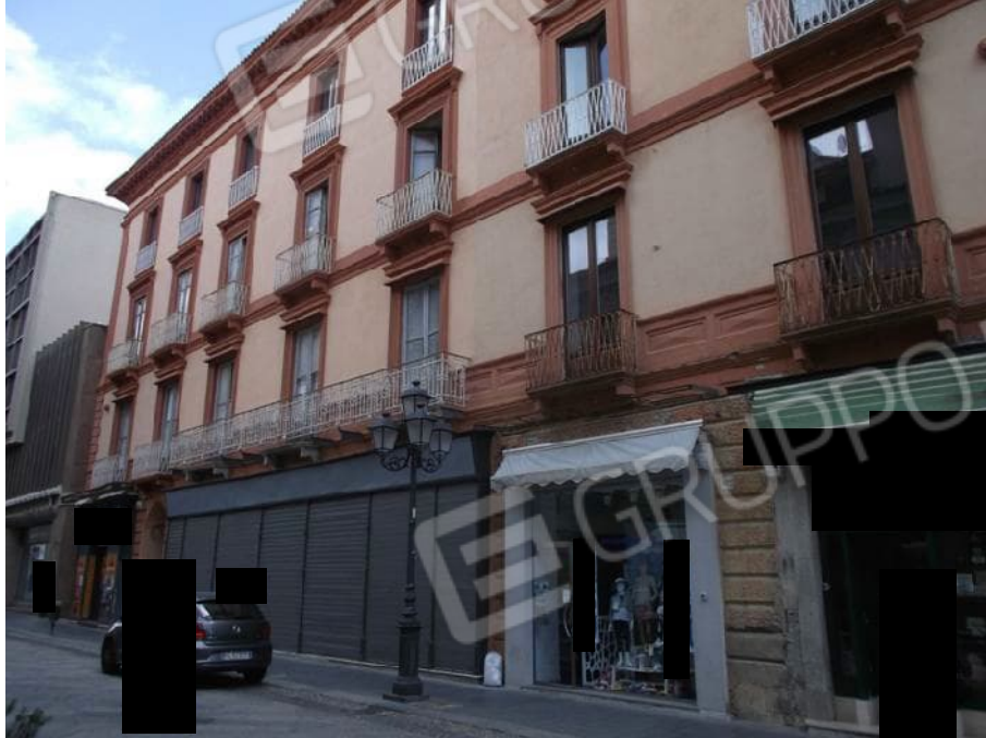
Vista da Corso G. Mazzini
