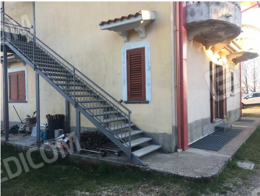
Foto 4 – Scala esterna per accesso piano primo
