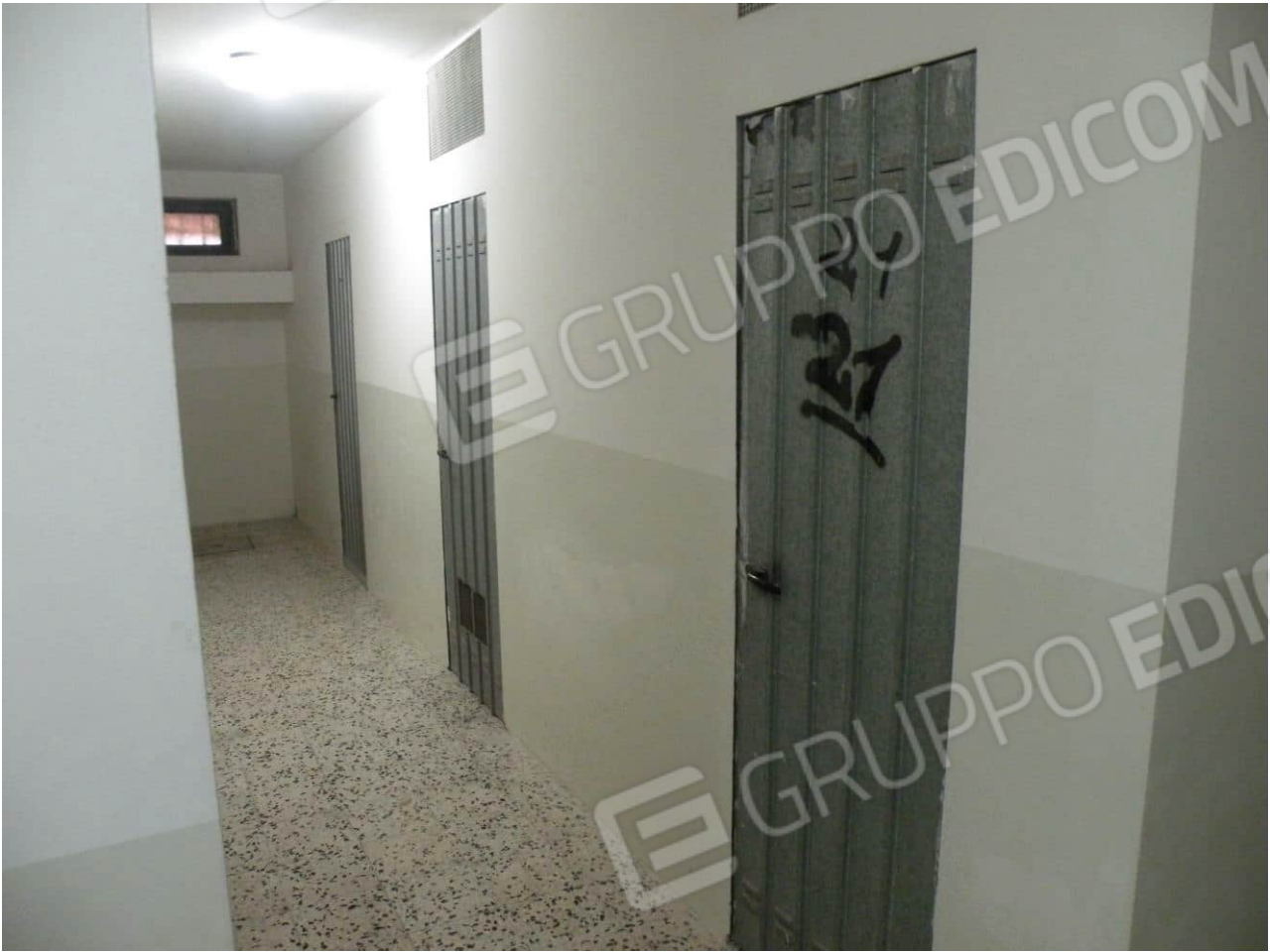
Foto n° 16 – Alloggio pignorato: Cantina di pertinenza al piano seminterrato (n° 21)
