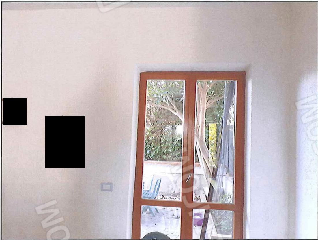
Foto 8. Porta finestra per accesso ad area esterna retrostante l'immobile
