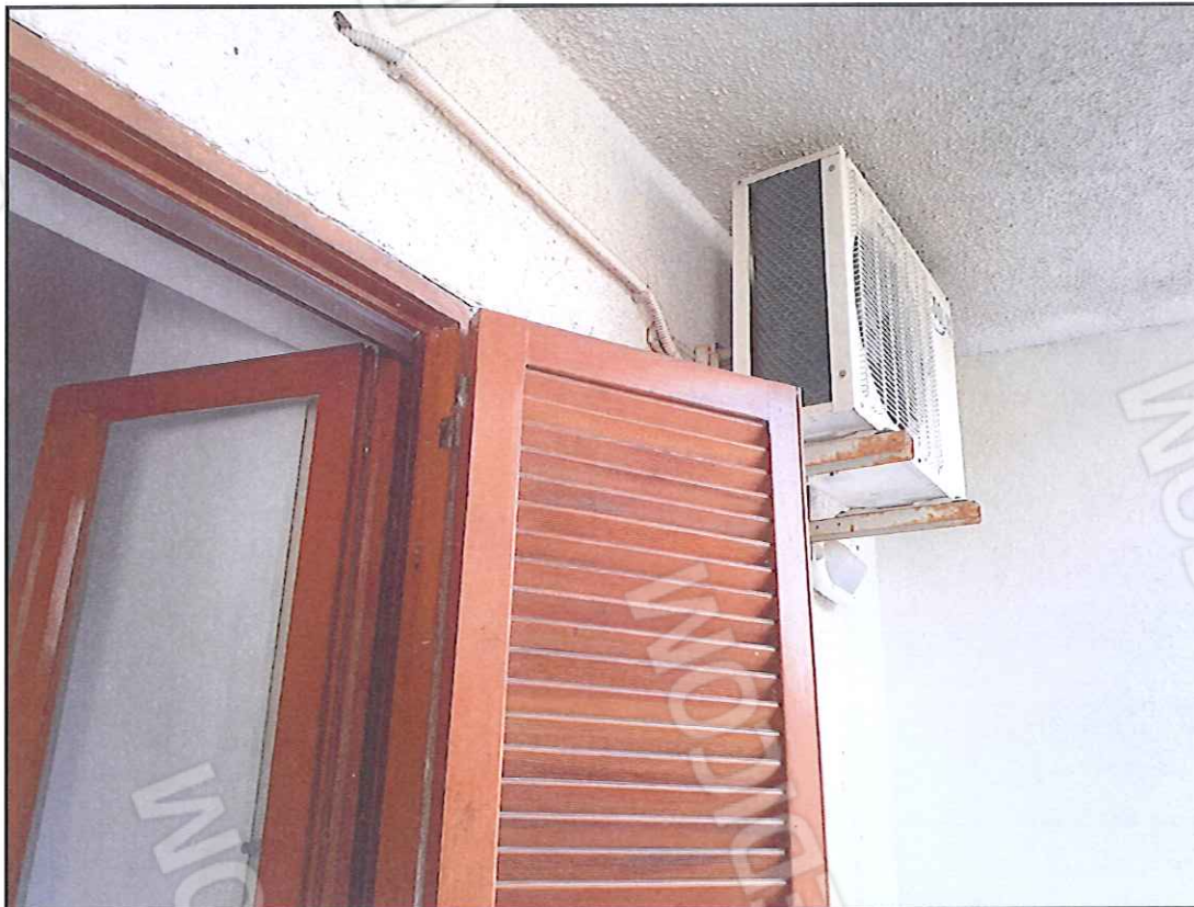
Foto 18. Vista balcone stanza da letto lato est con unità esterna climatizzazione
