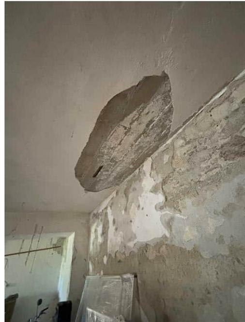
**Figura 8: (a sinistra) Piano Seminterrato ambiente unico - (a destra) criticità solaio di copertura**
