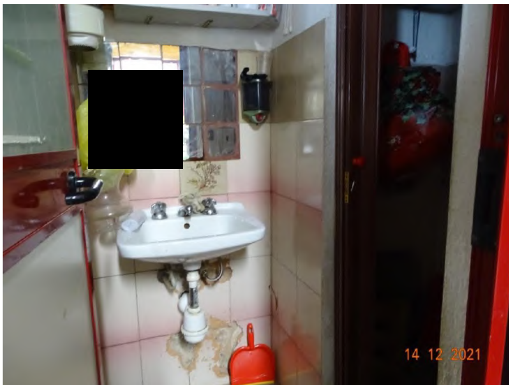
Foto 13 – Particolare del piccolo servizio igienico immobile “B”
