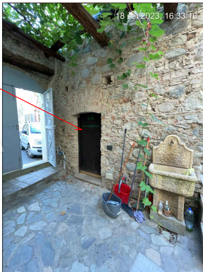
Foto 14 - Ingresso locale piano terra
