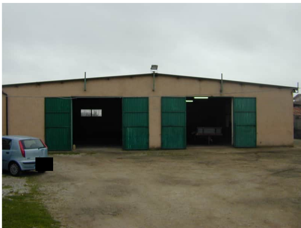
Figura 1 : L'insieme delle due entrate del capannone sito in Belcastro - C.da Fieri
