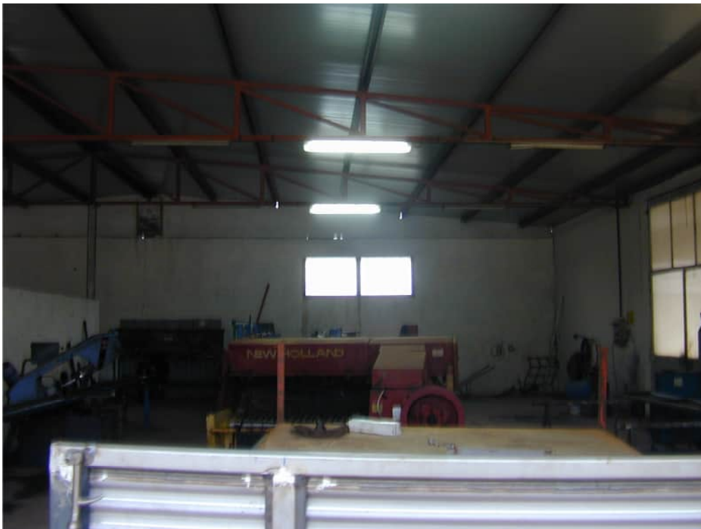
Figura 3 : Particolare dell'interno del capannone.
