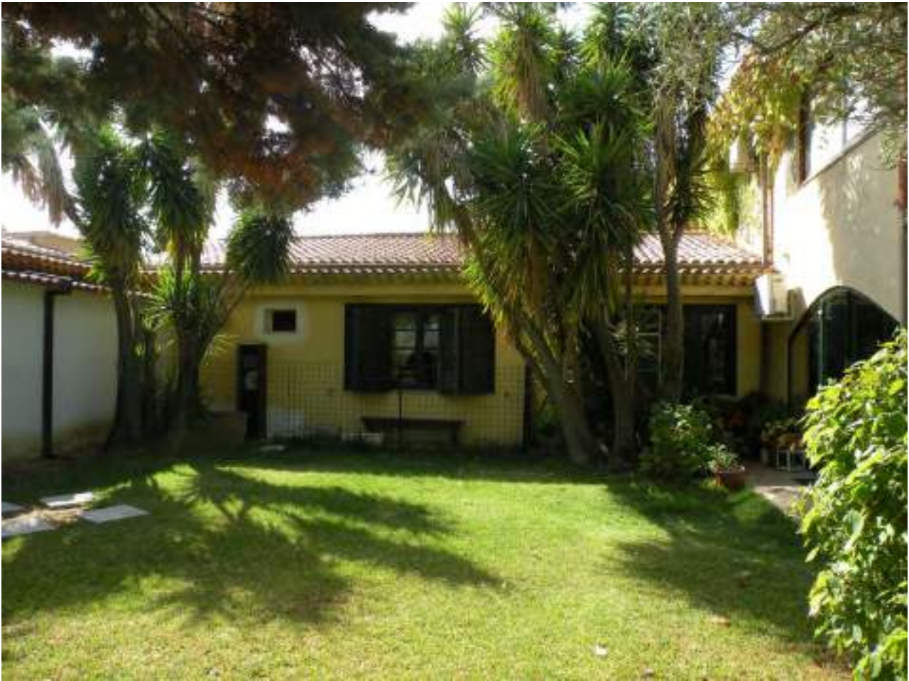
Foto n° 7 – Immobile censito nel N.C.E.U. al fg 5 par.IIa 584 sub1 – Prospetto Est
