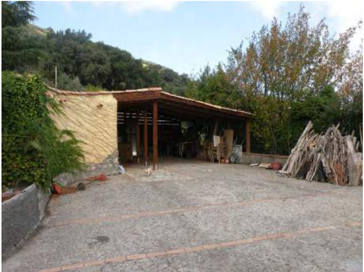
Foto n° 13 – Immobile censito nel N.C.E.U. al fg 5 par.lla 584 sub1 - Magazzino con tettoia realizzato sulla par.lla 797 di proprietà di terzi, contenente serbatoio GPL
