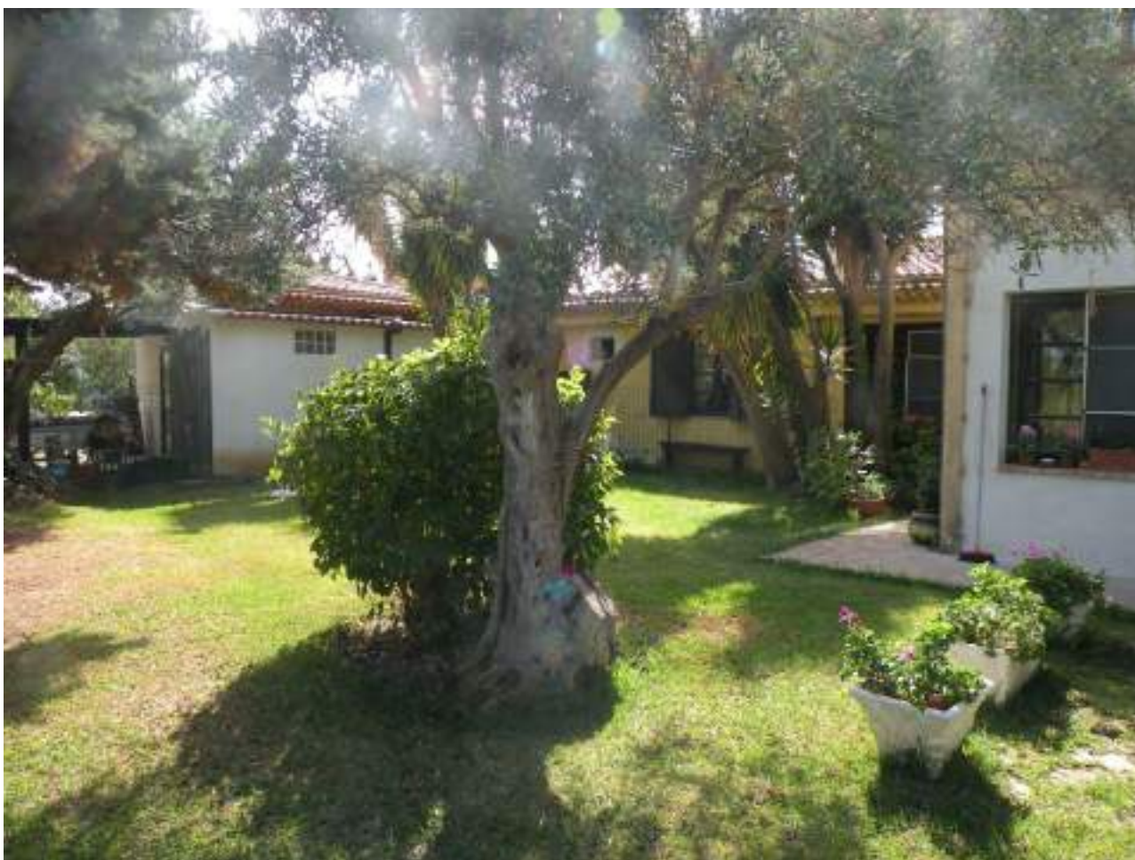
Foto n° 6 – Immobile censito nel N.C.E.U. al fg 5 par.la 584 sub1 – Prospetto Est
