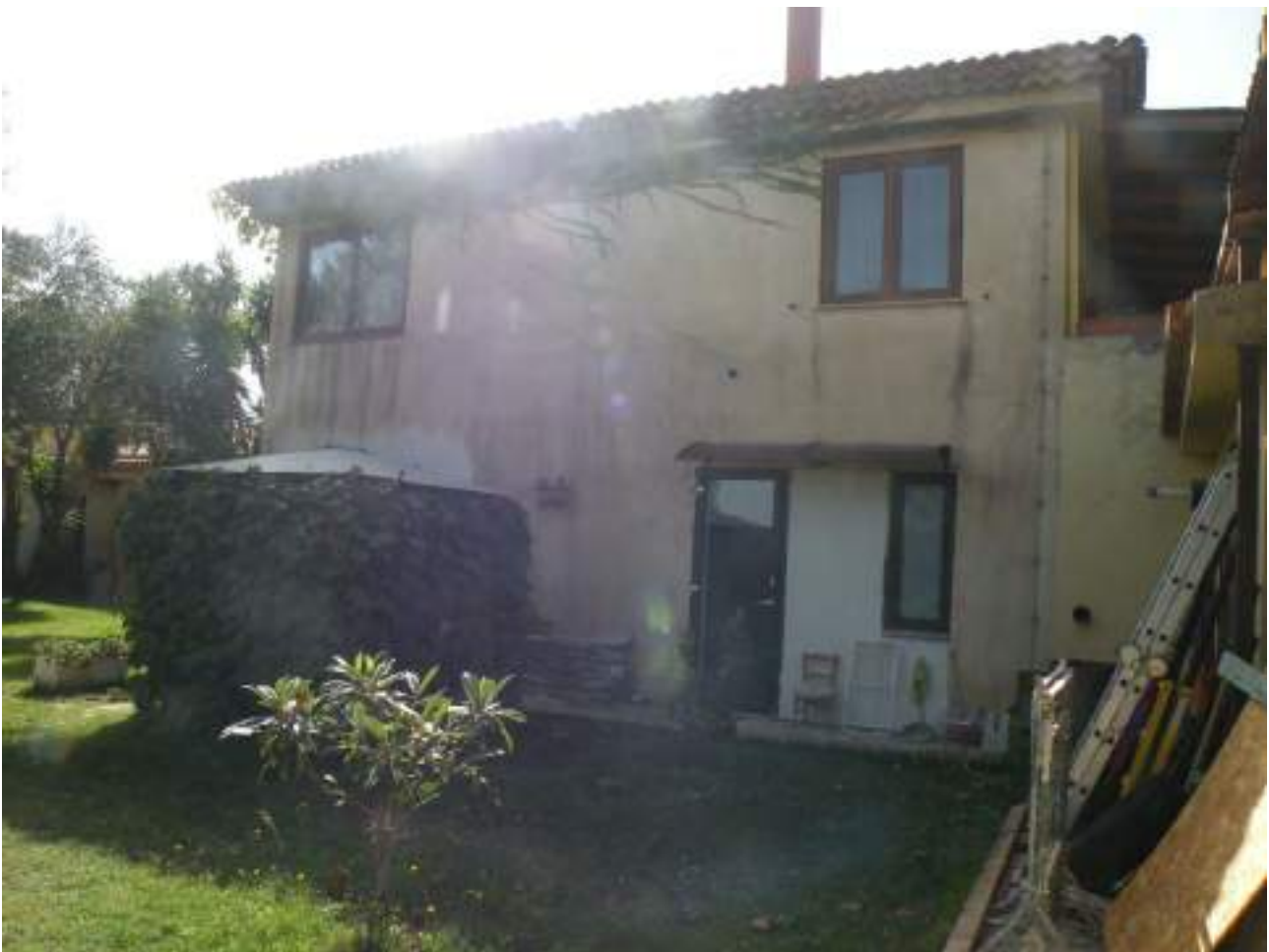
Foto n° 8 – Immobile censito nel N.C.E.U. al fg 5 par.IIa 584 sub1 – Prospetto Est
