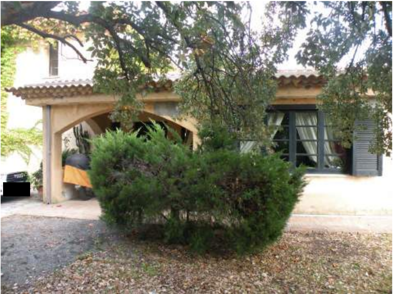
Foto n° 3 – Immobile censito nel N.C.E.U. al fg 5 par.IIa 584 sub1 – Prospetto Ovest
