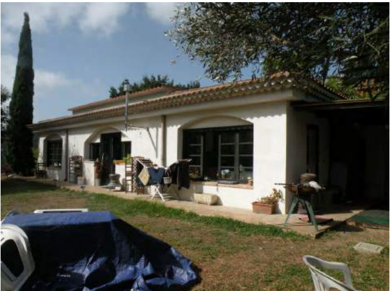
Foto n° 4 – Immobile censito nel N.C.E.U. al fg 5 par.IIa 584 sub1 – Prospetto Sud
