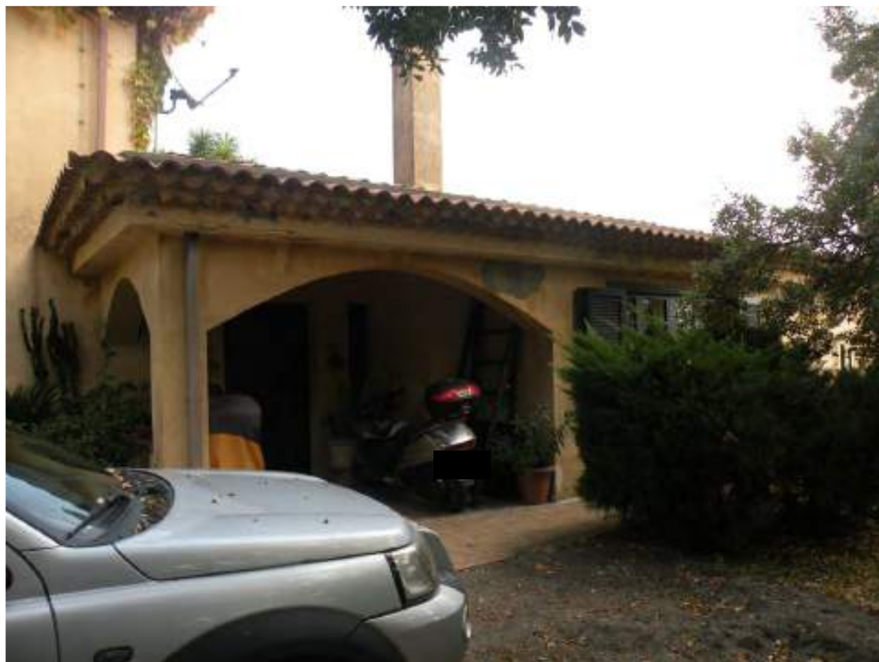
Foto n° 2 – Immobile censito nel N.C.E.U. al fg 5 par.lla 584 sub1 – Prospetto Ovest
