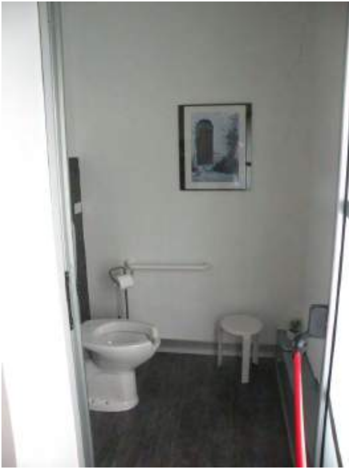
Foto n° 42 – Immobile censito nel N.C.E.U. al fg 64 par.la 148 sub31 - WC
