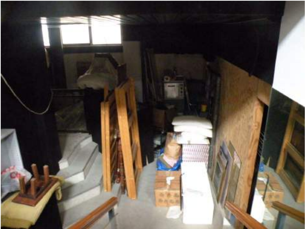
Foto n° 49 – Immobile censito nel N.C.E.U. al fg 64 par.lla 148 sub 32 – Piano Seminterrato
