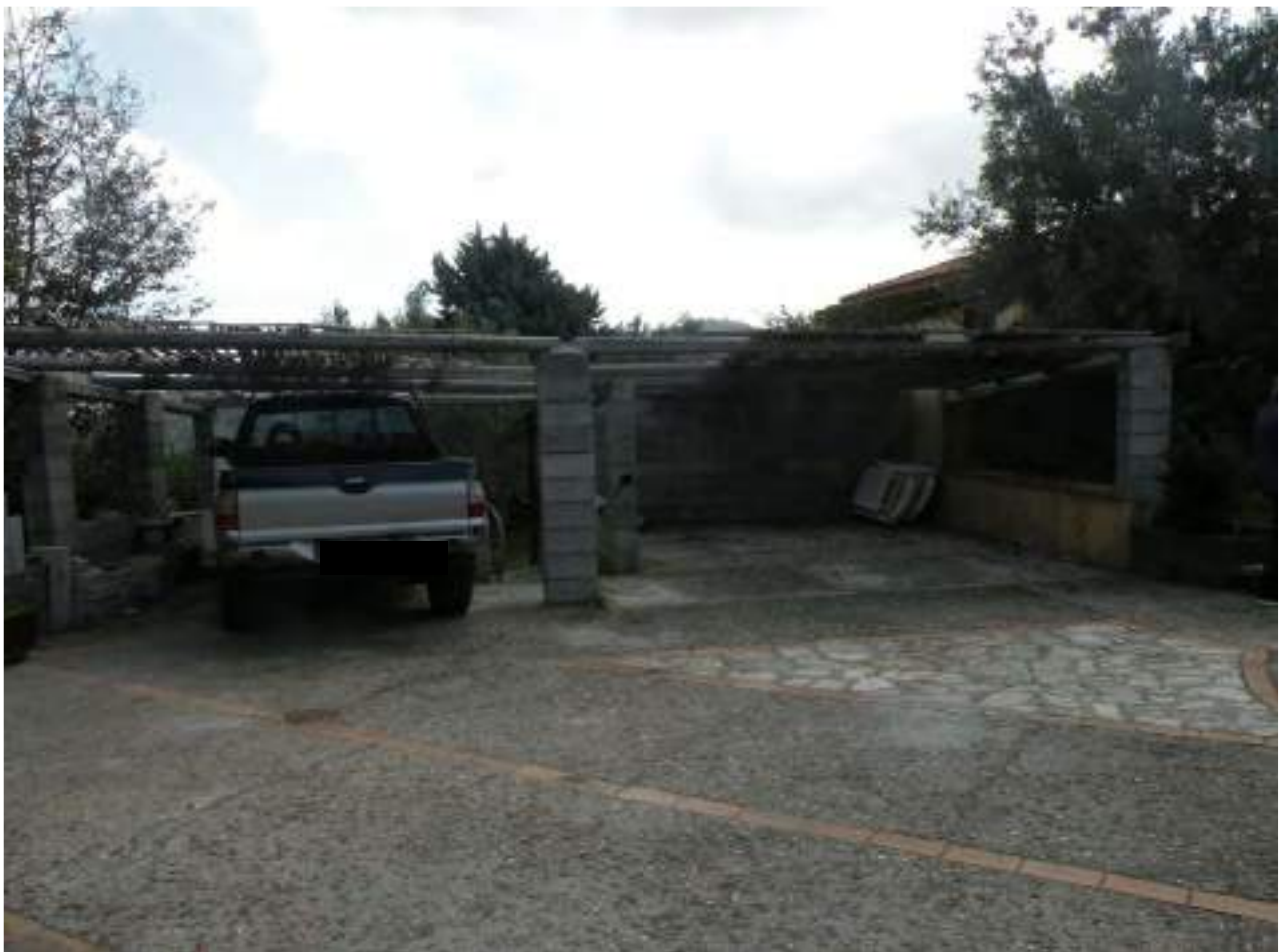
Foto n° 12 – Immobile censito nel N.C.E.U. al fg 5 par.lla 584 sub1 - Pergolato nella corte lato Nord
