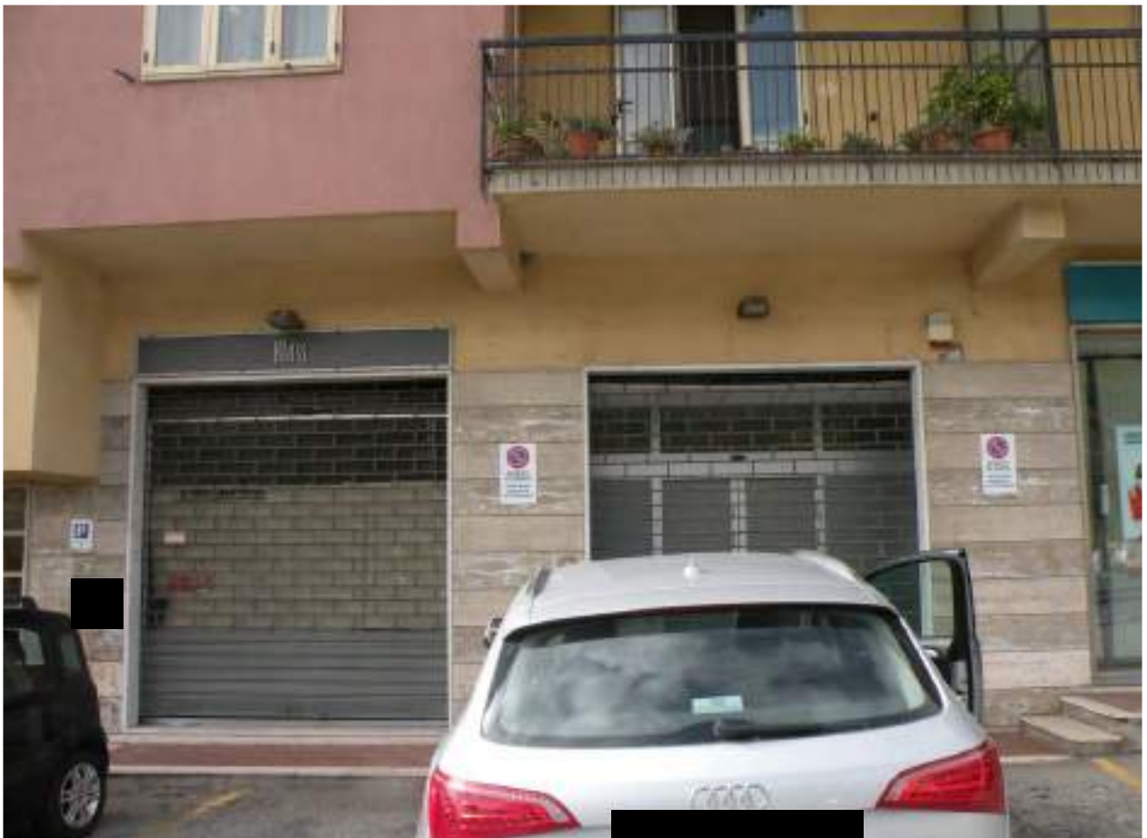
Foto n° 44 – Immobile censito nel N.C.E.U. al fg 64 par.la 148 sub 32 – P.T. - Ingresso dall'esterno
