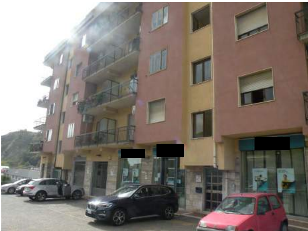
Foto n° 35 – Edificio condominiale in cui sono ubicati gli immobili censiti nel N.C.E.U. al foglio 64 particella 148 sub 31 e 32 - Prospetto principale (Est)
