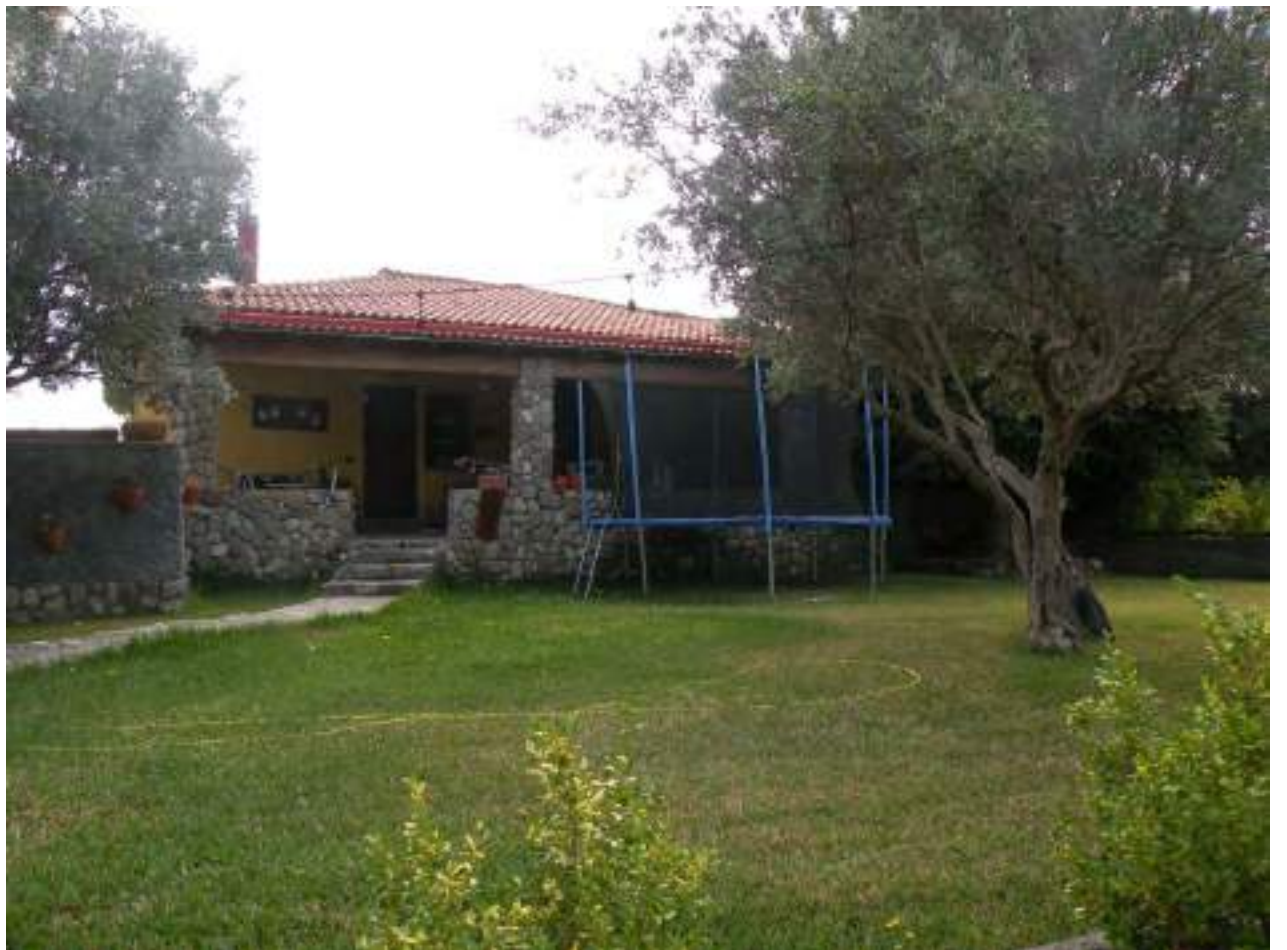
Foto n° 10 – Immobile censito nel N.C.E.U. al fg 5 par.lla 584 sub1 – Prospetto Nord – P. 1°
