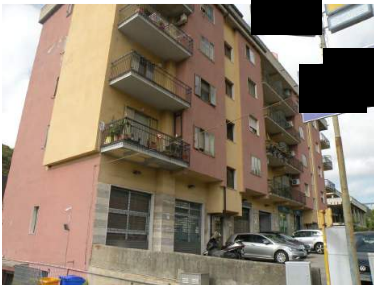
Foto n° 34 – Edificio condominiale in cui sono ubicati gli immobili censiti nel N.C.E.U. al foglio 64 particella 148 sub 31 e 32 - Prospetto principale (Est)
