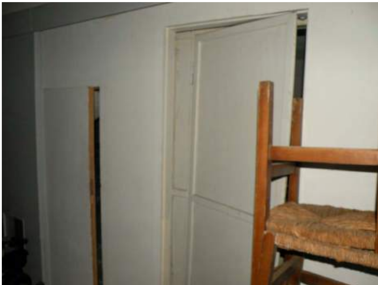
Foto n° 51 – Immobile censito nel N.C.E.U. al fg 64 par.IIa 148 sub 32 – P. Seminterrato – Ripostigli
