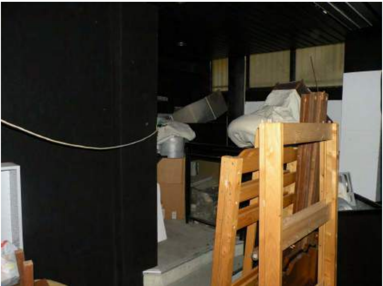
Foto n° 50 – Immobile censito nel N.C.E.U. al fg 64 par.lla 148 sub 32 – Piano Seminterrato
