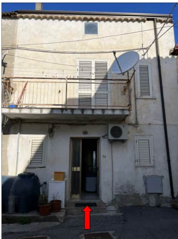
Fig. 4 – VISTA DAL LATO INGRESSO VIA PULLANO N. 71
