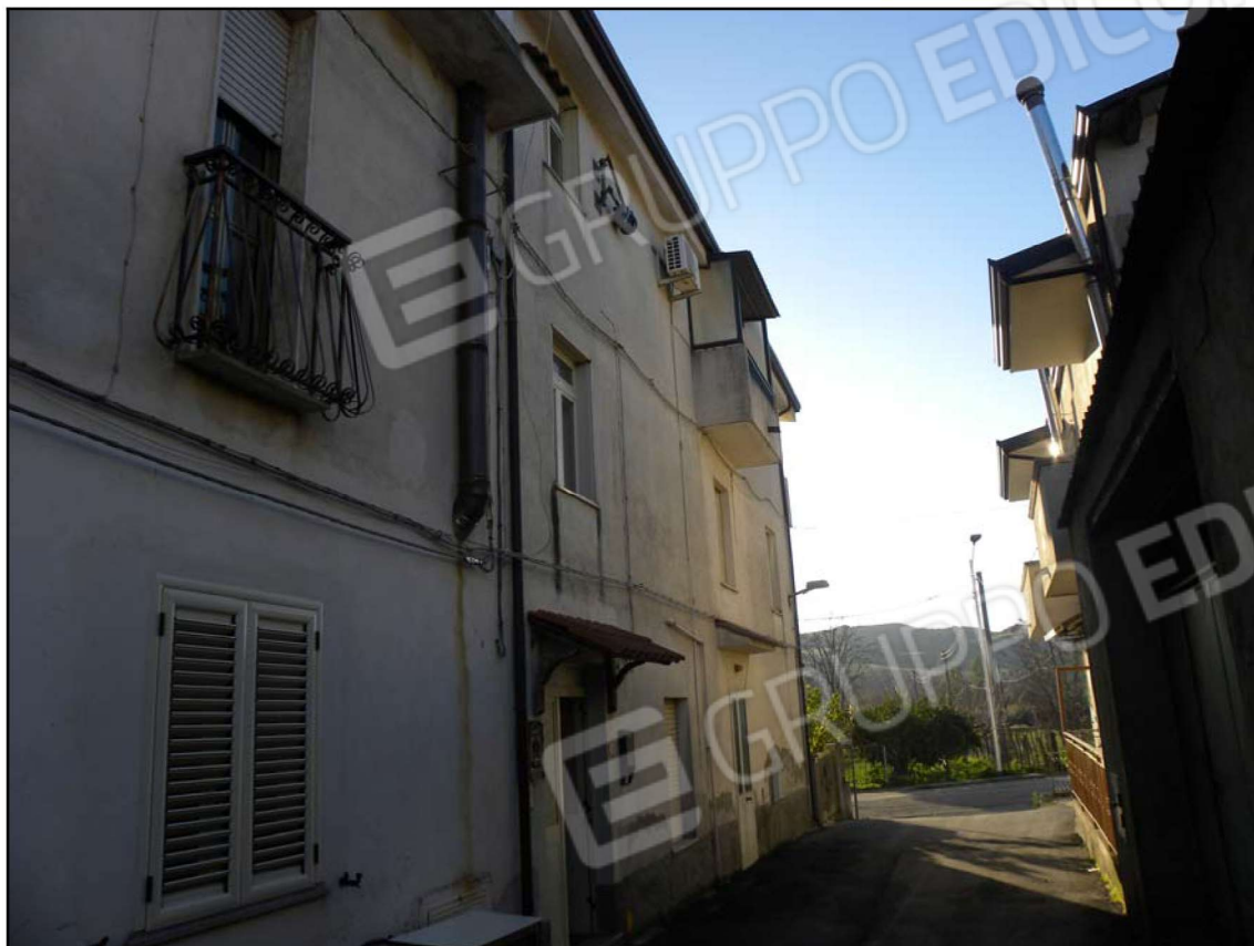
Foto 03 – Ingresso Fabbricato dove è posto il bene oggetto di pignoramento da Via Locri
