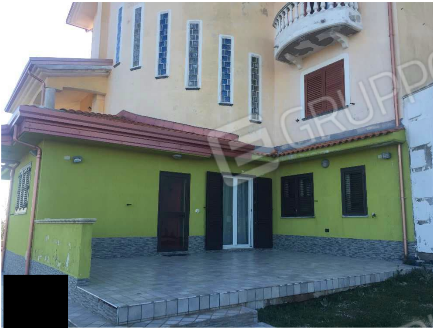
Foto 5 – Veduta esterna ingresso piano seminterrato
