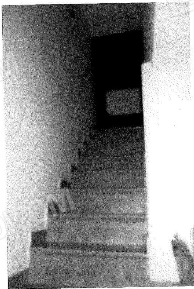
Foto n° 13 - scale di accesso al terrazzo e soffitta
