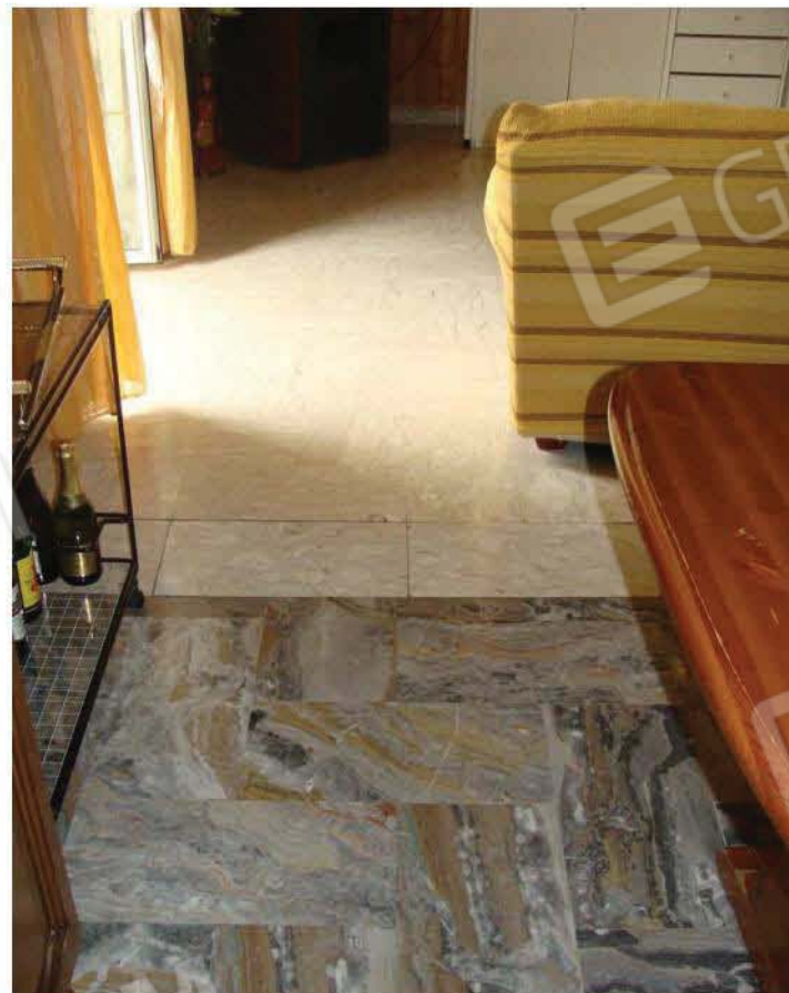
Illustrazione 18: Dettaglio pavimento locale cucina-soggiorno (cambio materiale rivestimento)
