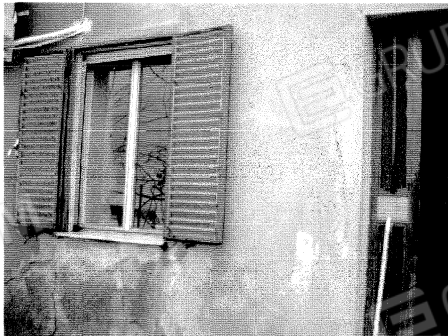
Foto n° 27 - Esterno fabbricato - particolare finestra P.T..
