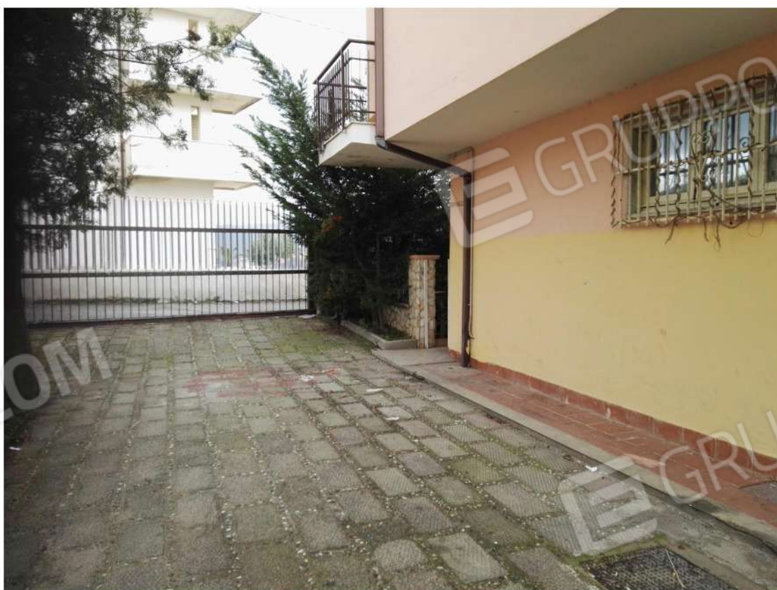
Foto 4 – esterni – corte di ingresso condominiale;
