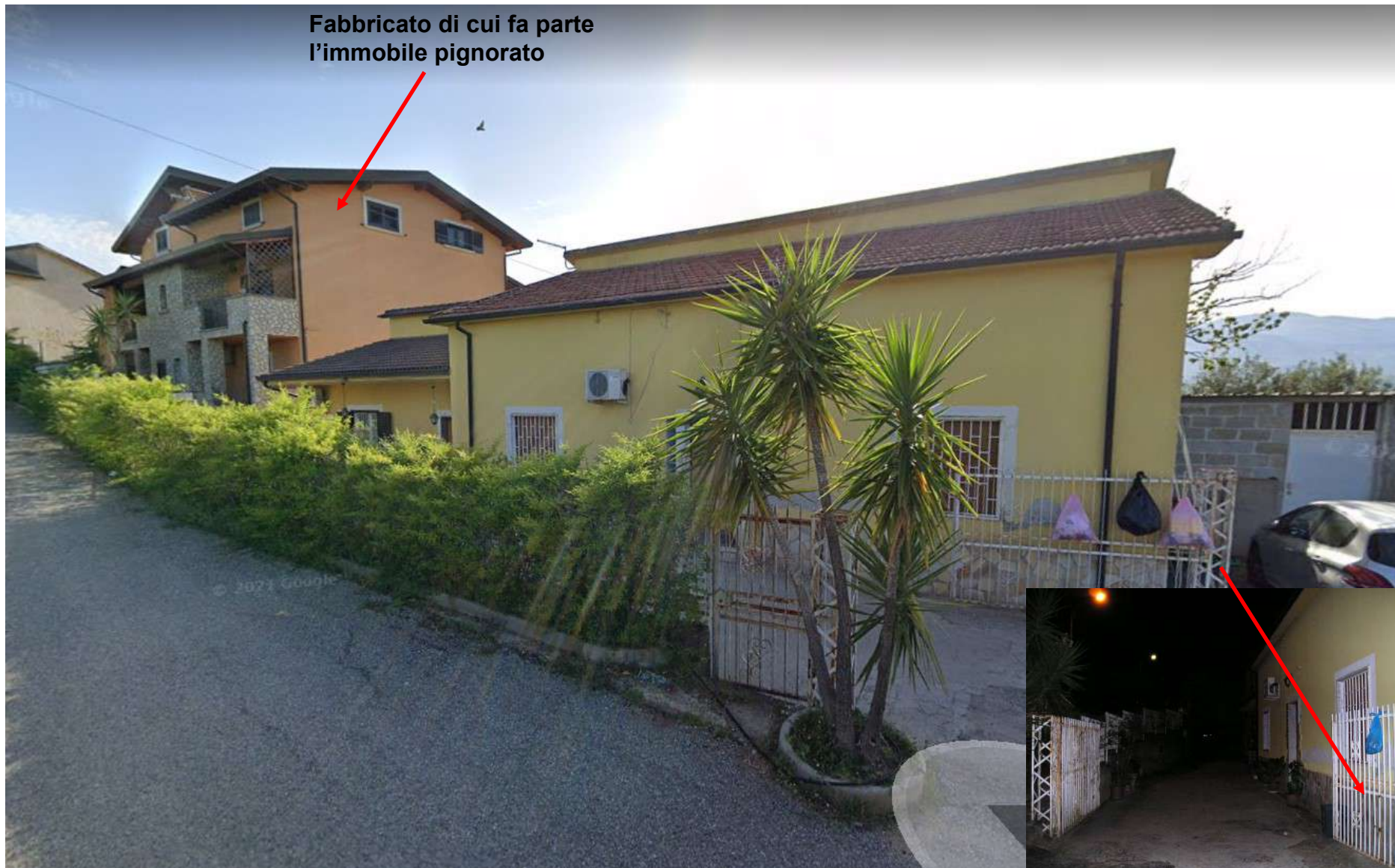
Foto n. 10: Particolare strada di accesso al fabbricato - immagine tratta da Google Maps
