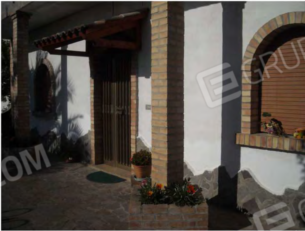
Foto n.12 Vista esterna ingresso principale su lato Sud
