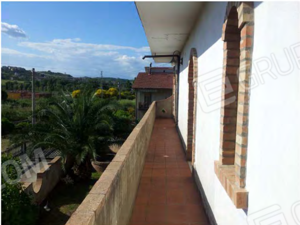
Foto n.20 Particolare esterno balcone
