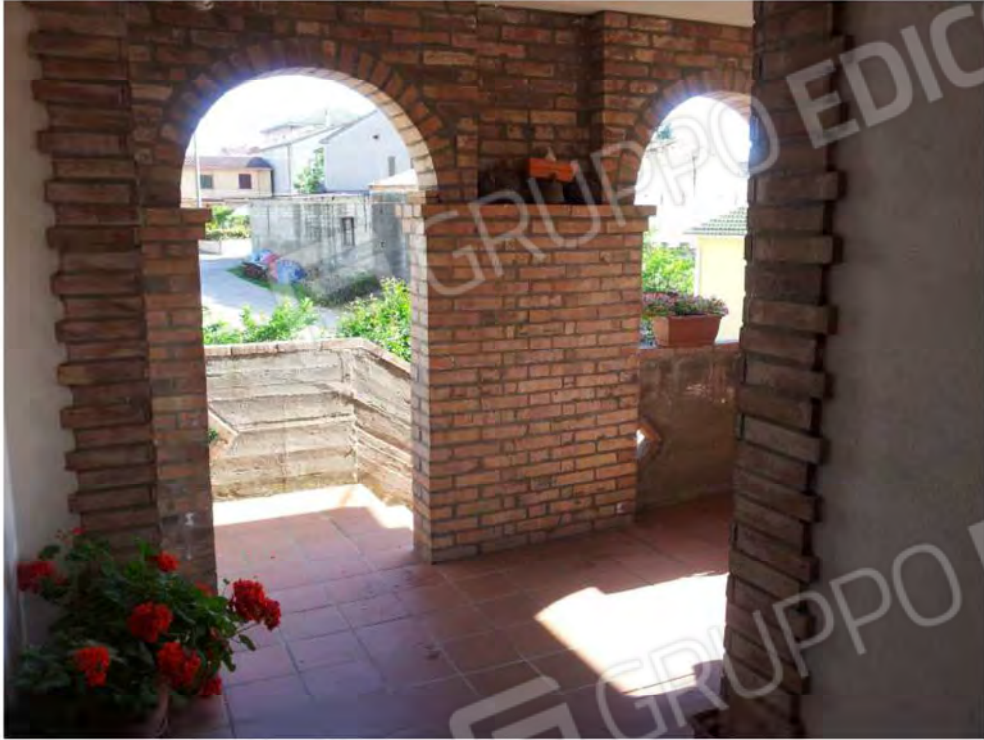
Foto n.17 Particolare esterno loggia di ingresso
