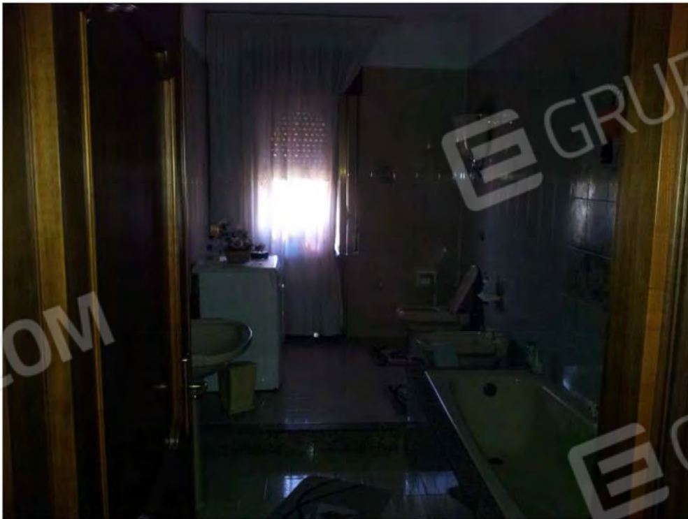
Foto n.14 Particolare interno bagno
