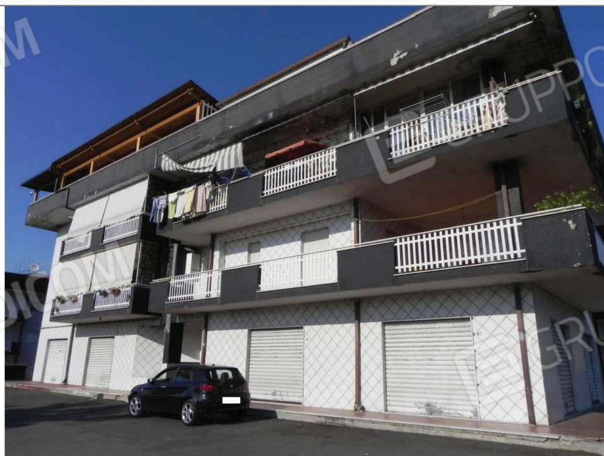
Foto n.2: prospetto lato OVEST
