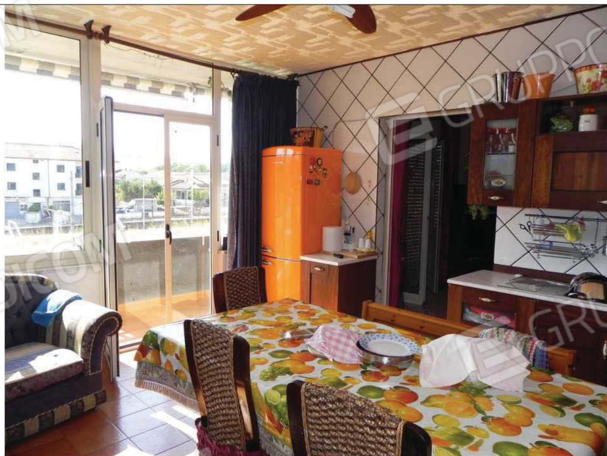
Foto n.28: terrazzo chiuso in difformità alla C.E.
