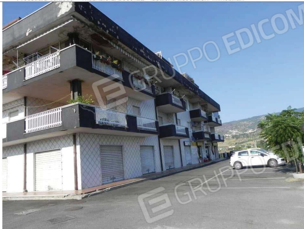
Foto n.1: prospetto lato SUD
