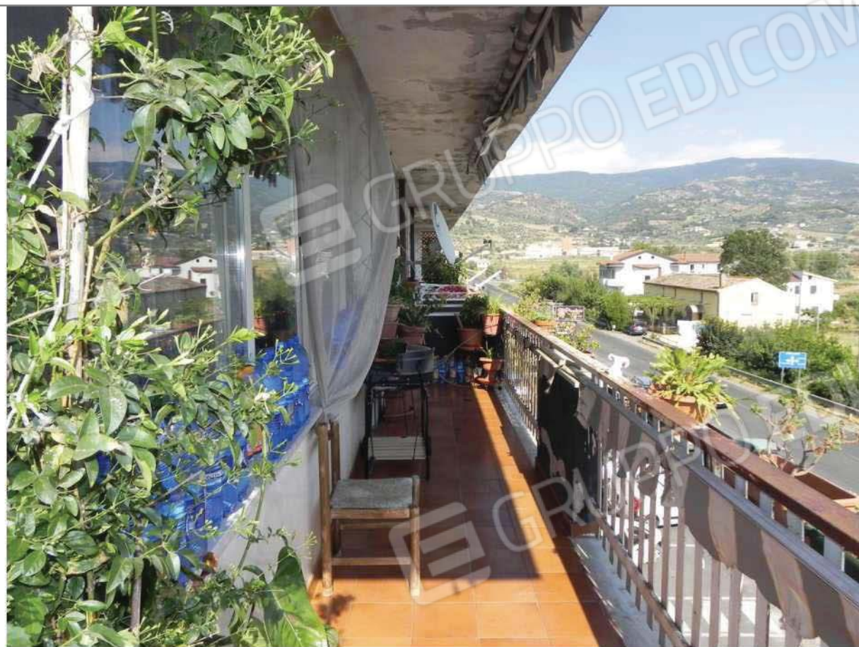
Foto n.31: particolare terrazzo lato sud
