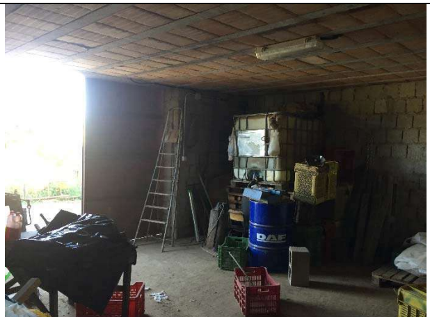
VISTA INTERNA PRIMO FABBRICATO DA SUD LIVELLO -1
