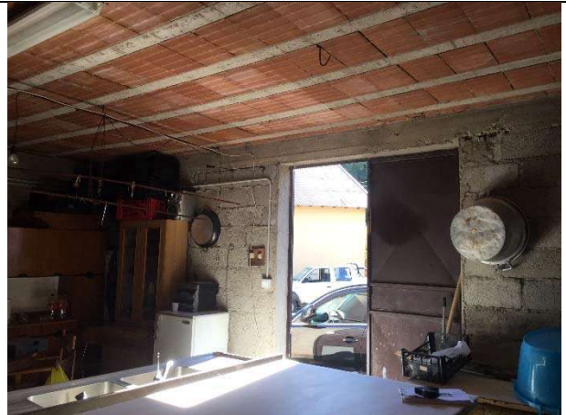
VISTA INTERNA PRIMO FABBRICATO DA SUD LIVELLO 1
