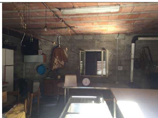
VISTA INTERNA PRIMO FABBRICATO DA SUD LIVELLO 1
