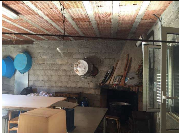
VISTA INTERNA PRIMO FABBRICATO DA SUD LIVELLO 1
