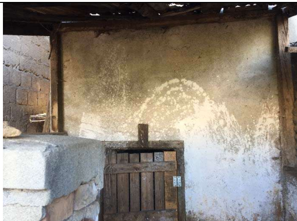
VISTA INTERNA DEL FABBRICATO INTERMEDIO ADIBITO A PORCILAIA LIVELLO -1
