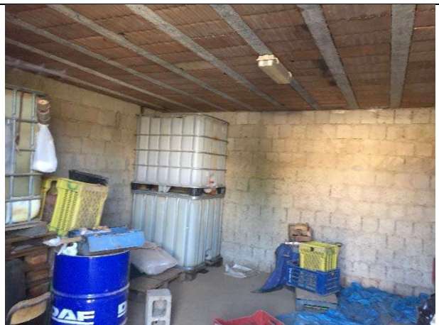
VISTA INTERNA PRIMO FABBRICATO DA SUD LIVELLO -1
