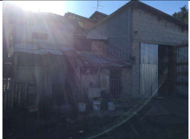
VISTA DEL FABBRICATO INTERMEDIO ADIBITO A PORCILAIA LIVELLO -1
