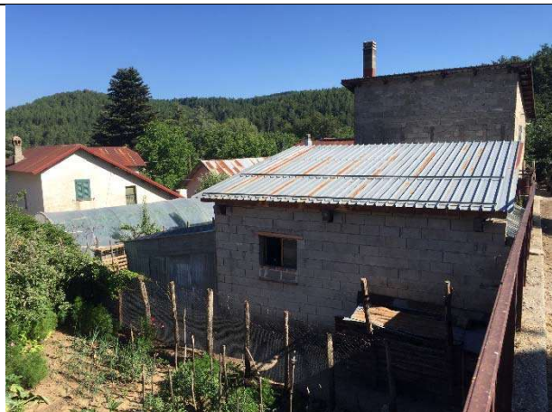
VISTA DEI FABBRICATI DA NORD
