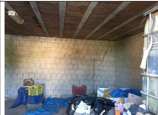
VISTA INTERNA PRIMO FABBRICATO DA SUD LIVELLO -1
