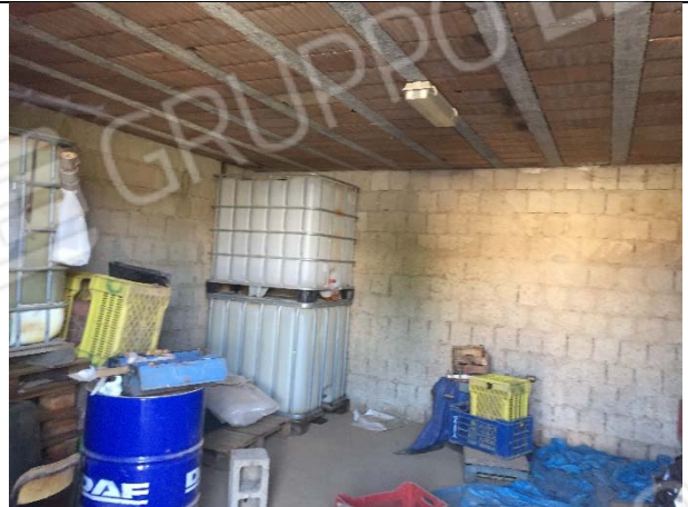
VISTA INTERNA PRIMO FABBRICATO DA SUD LIVELLO -1
