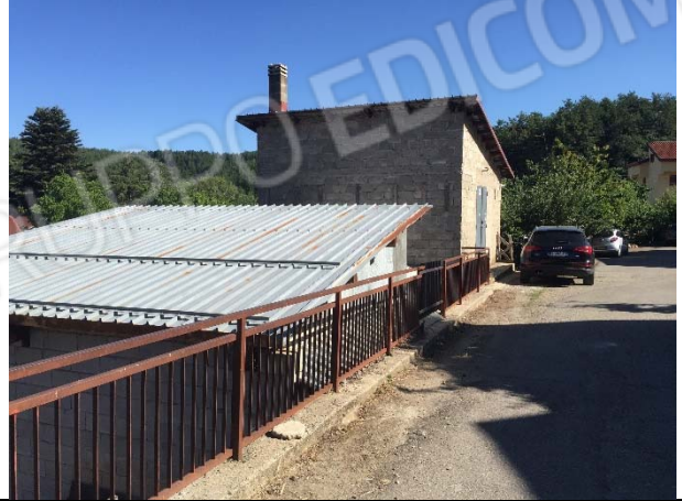
VISTA DEI FABBRICATI DA NORD SU STRADA COMUNALE
