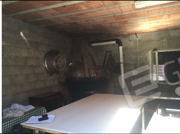
VISTA INTERNA PRIMO FABBRICATO DA SUD LIVELLO 1
