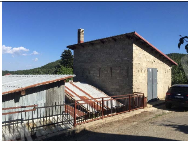
VISTA DEI FABBRICATI DA EST SU STRADA COMUNALE
