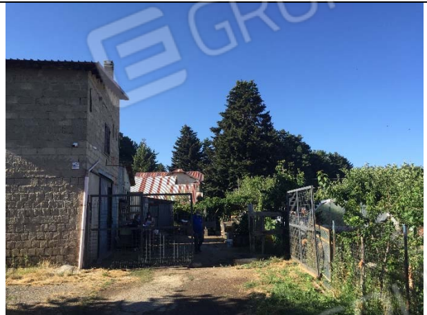
VISTA ZONA DI ACCESSO DA SUD LIVELLO -1 SU STRADA DI SERVIZIO
