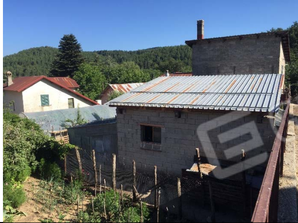
VISTA DEI FABBRICATI DA NORD
