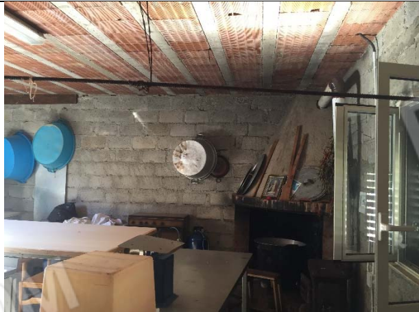
VISTA INTERNA PRIMO FABBRICATO DA SUD LIVELLO 1
