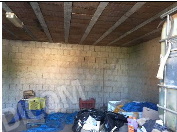
VISTA INTERNA PRIMO FABBRICATO DA SUD LIVELLO -1
