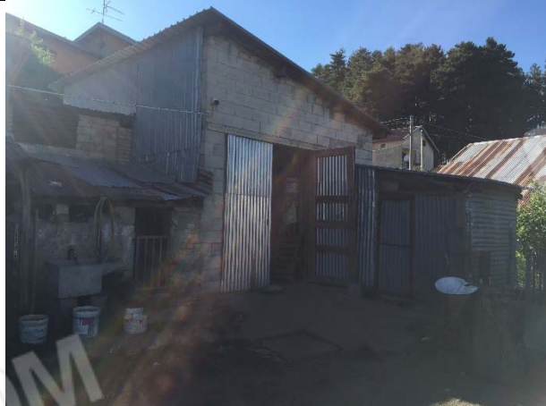
VISTA DELL'ULTIMO FABBRICATO A COMINCIARE DA SUD - LIVELLO -1 SU CORTE INTERNA FRONTE EST
