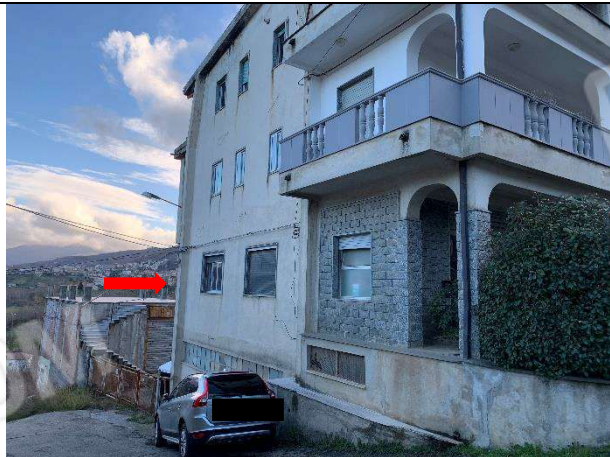
VISTA FRONTE NEGOZIO (Cespite 3) DA STRADA LATERALE
