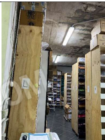
VISTA INTERNA SECONDO MAGAZZINO (Cespite 2)
