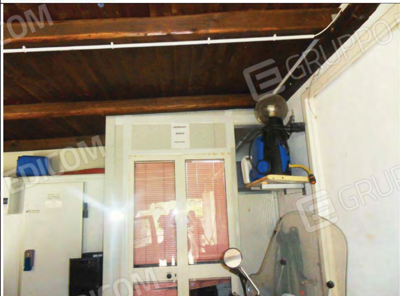
FOTO N. 236: Esterni BENE N. 3
