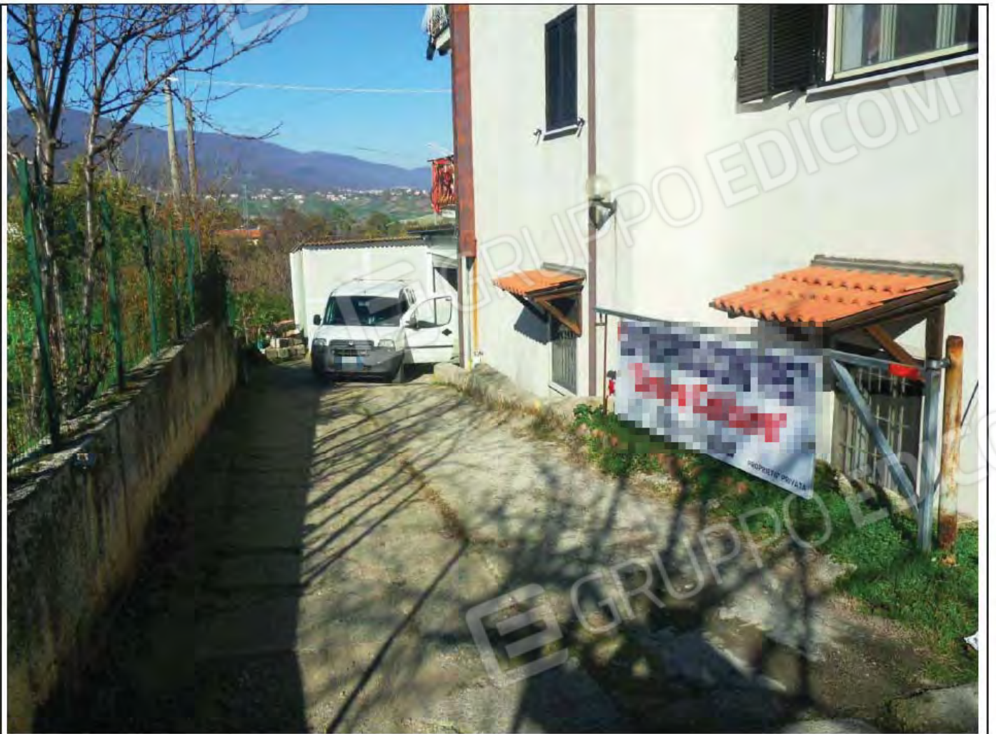
FOTO N. 5: Prospetto SUD-OVEST (Ingresso Bene N. 3)
