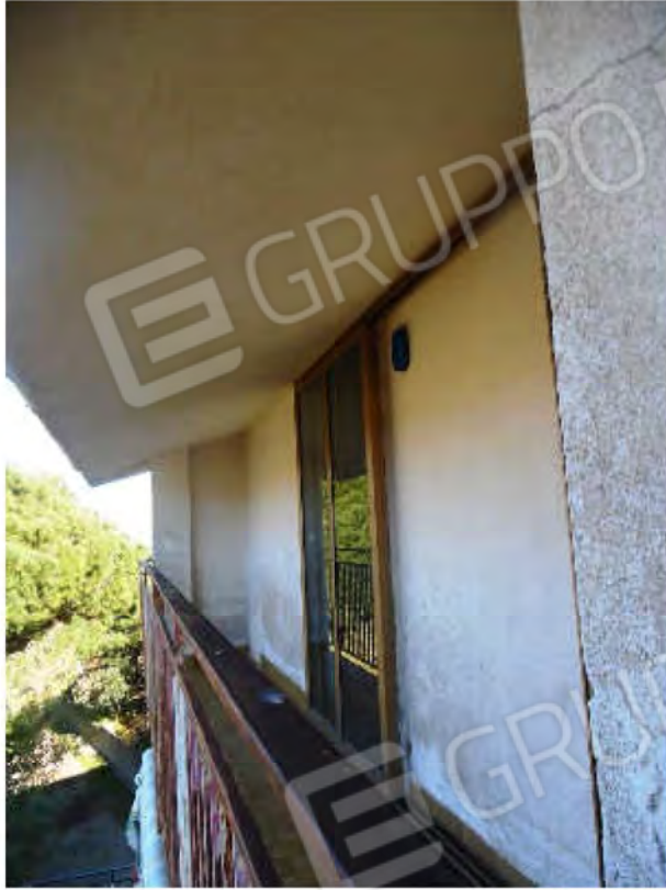
FOTO 33. Balcone Bagno lato Ovest
