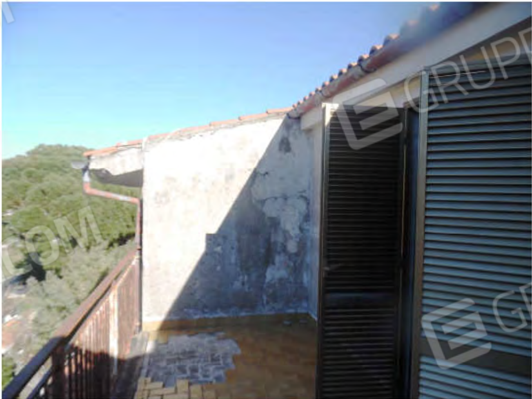
FOTO 28: terrazzo lato Ovest
