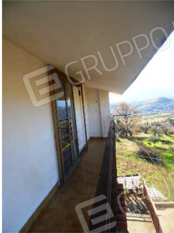
FOTO 24: balcone lato Ovest
