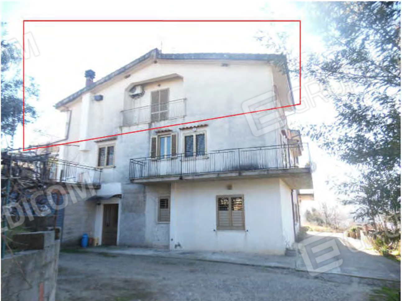
FOTO 4: Prospetto Lato Nord
