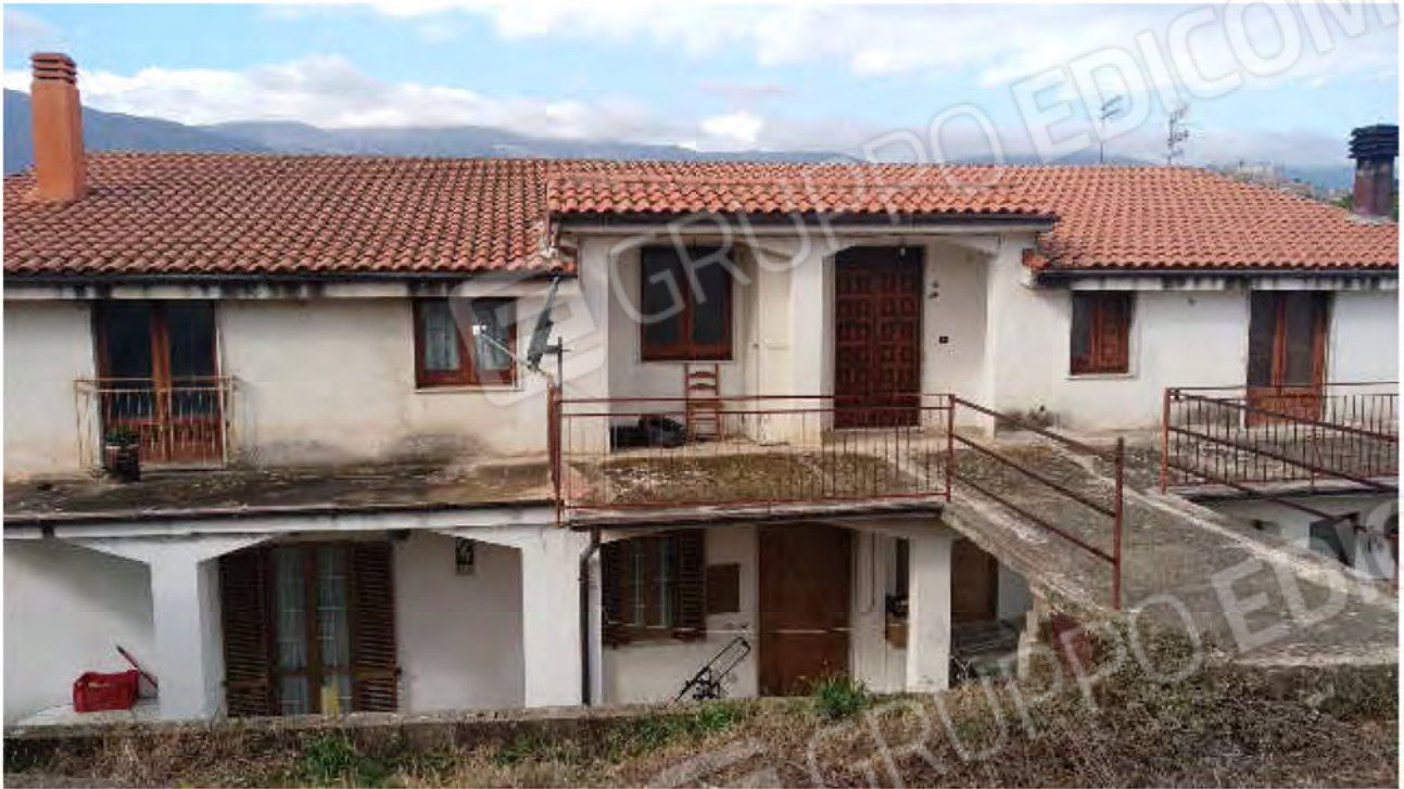
FOTO 9: Prospetto Lato Est - passerella di accesso
