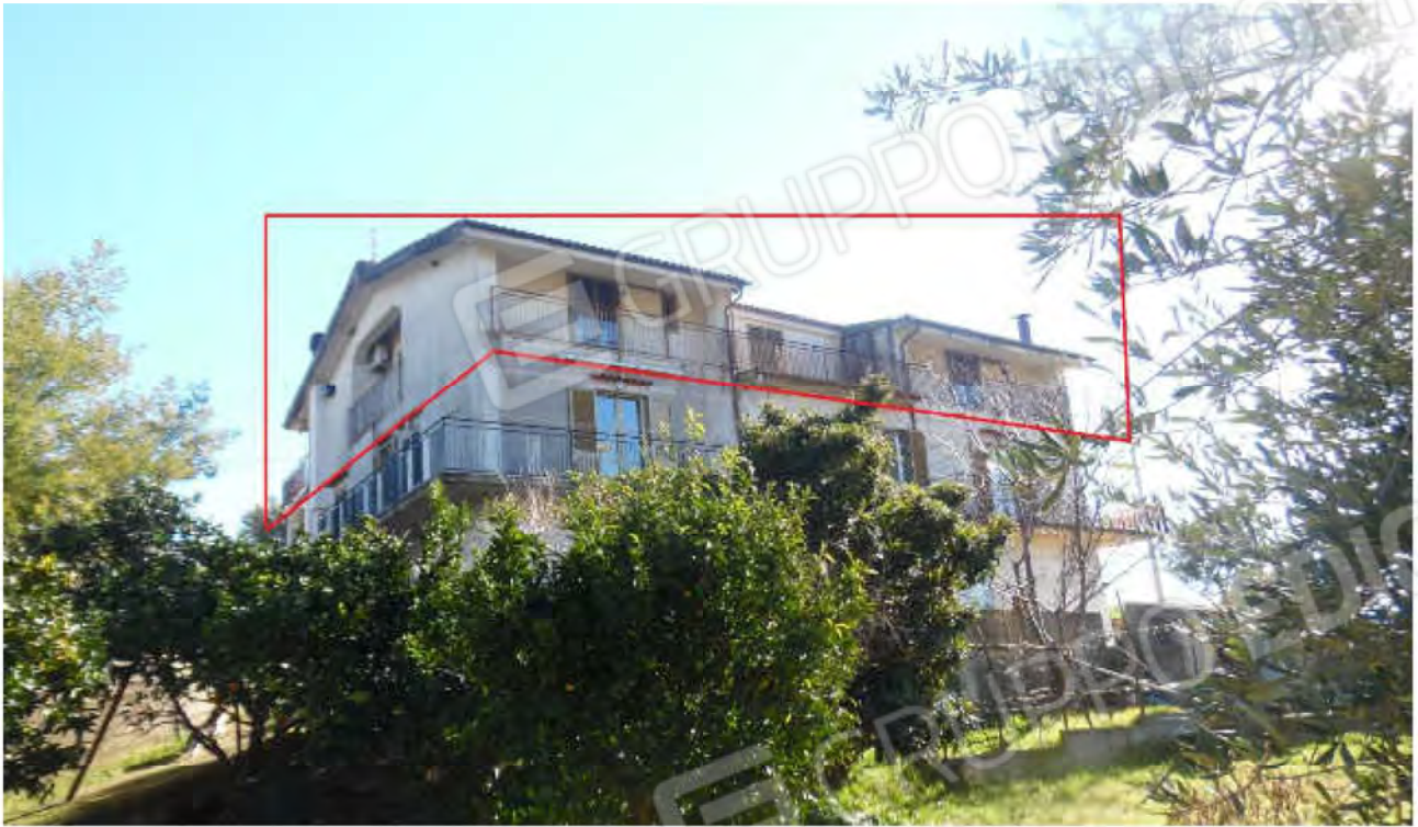
FOTO 3: Vista dei prospetti Nord ed Ovest
