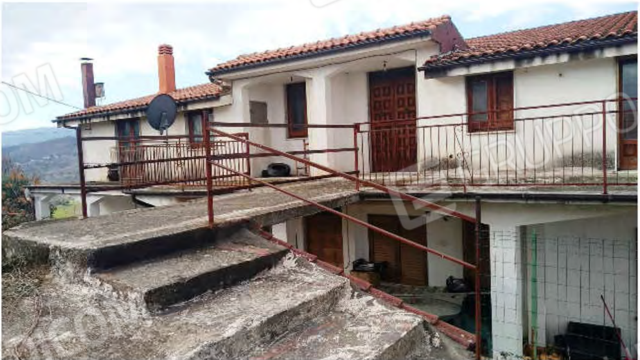
FOTO 10: Prospetto Lato Est - passerella di accesso
