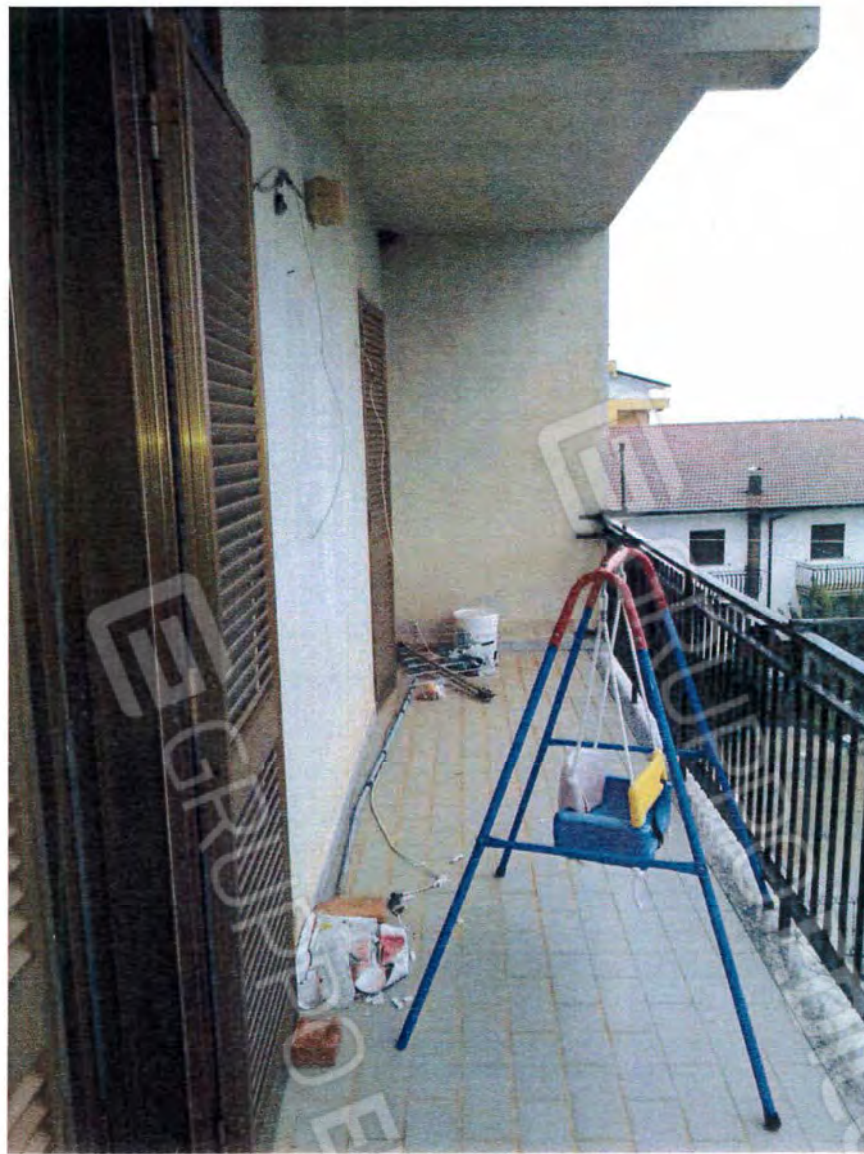
Foto n°12 :-Balcone sul prospetto a sud;
