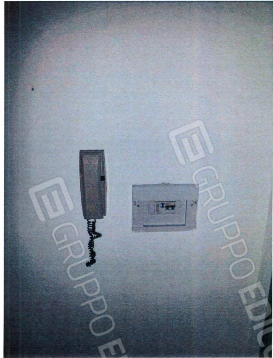
Foto n°14 :-Particolare Zona ingresso (citofono e quadretto distribuzione energia elettrica);
