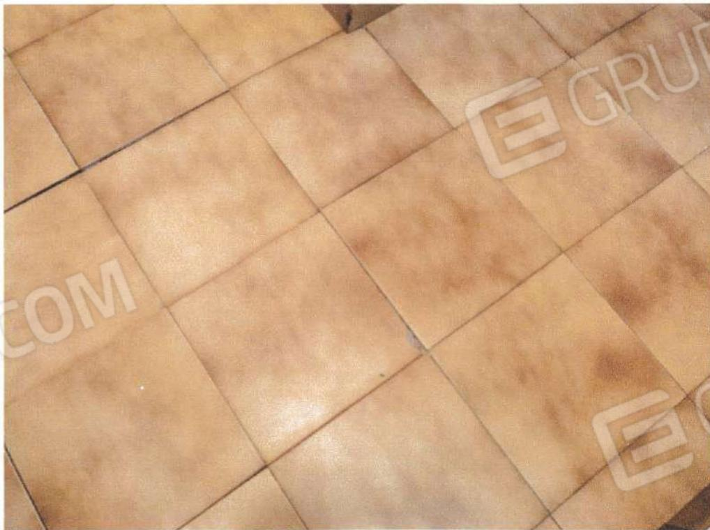
**FOTO 12: PAVIMENTO SCONNESSO E SUPERFICIE IRREGOLARE.**
