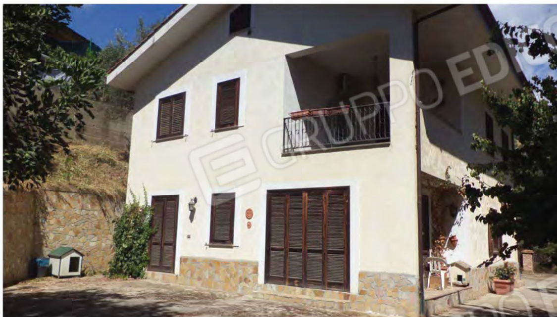
Foto n. 3: Vista Ovest del Fabbricato di Via Cappuccini.
